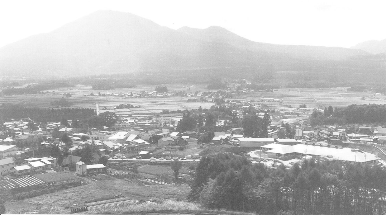
北東より全景
