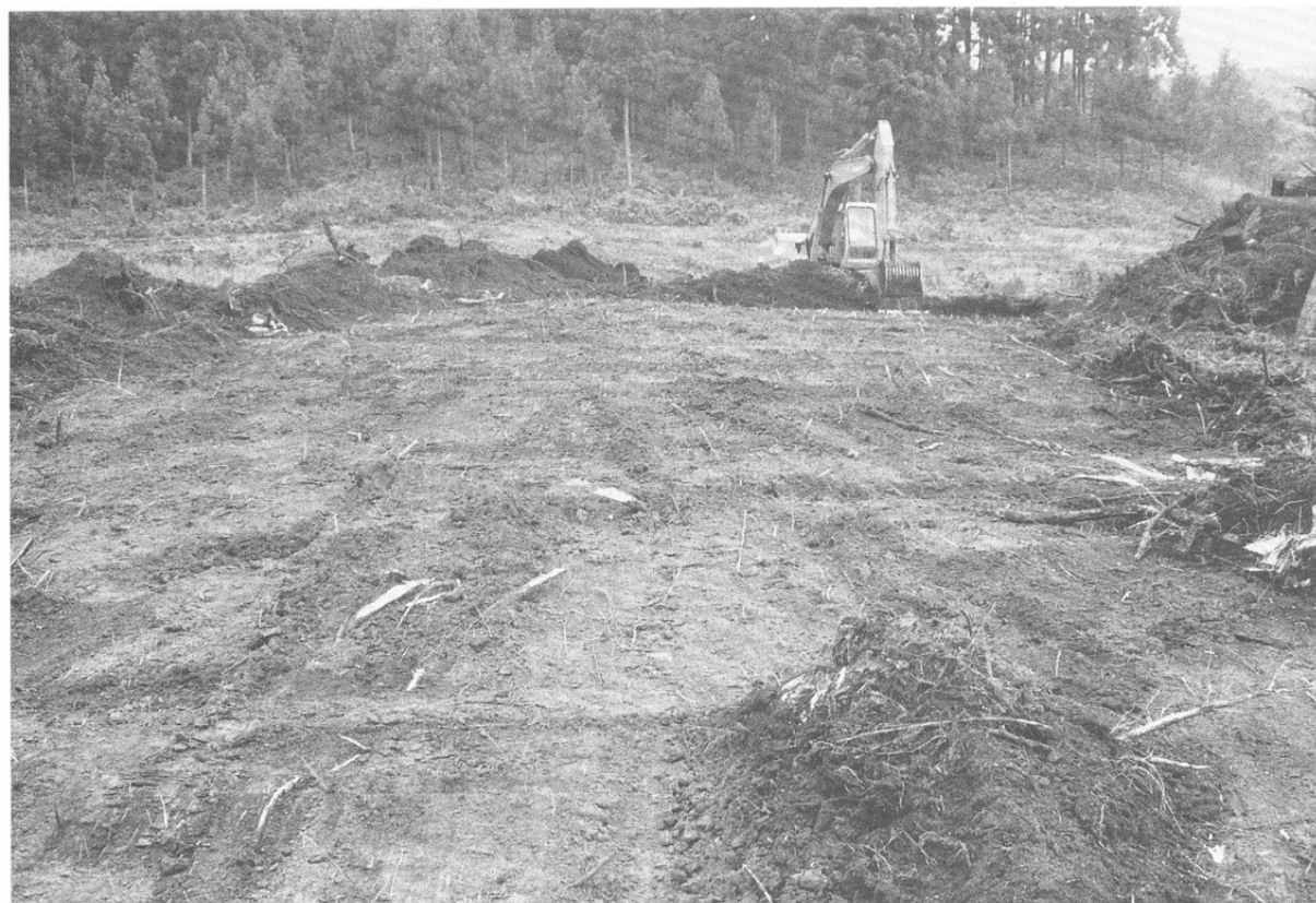
▼ 重機による表土除去作業
