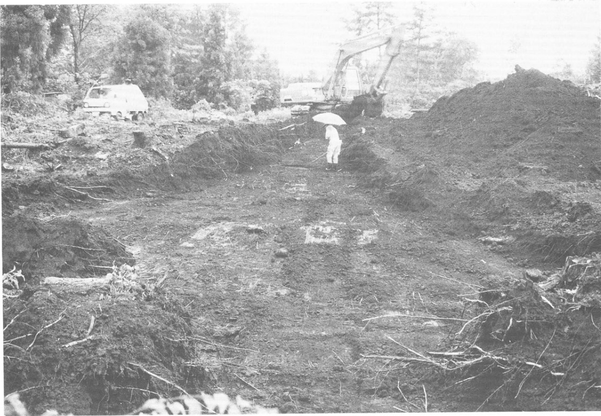
▲ 重機による表土除去作業
