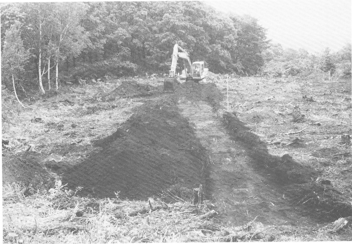
▲ 重機による表土除去作業
