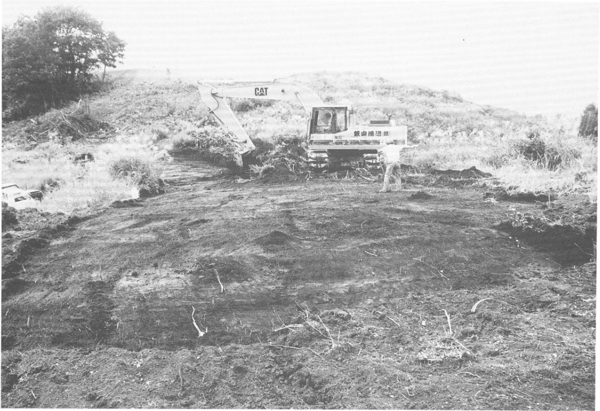
▲ 重機による表土除去作業
