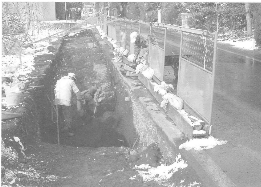
D区作業風景
