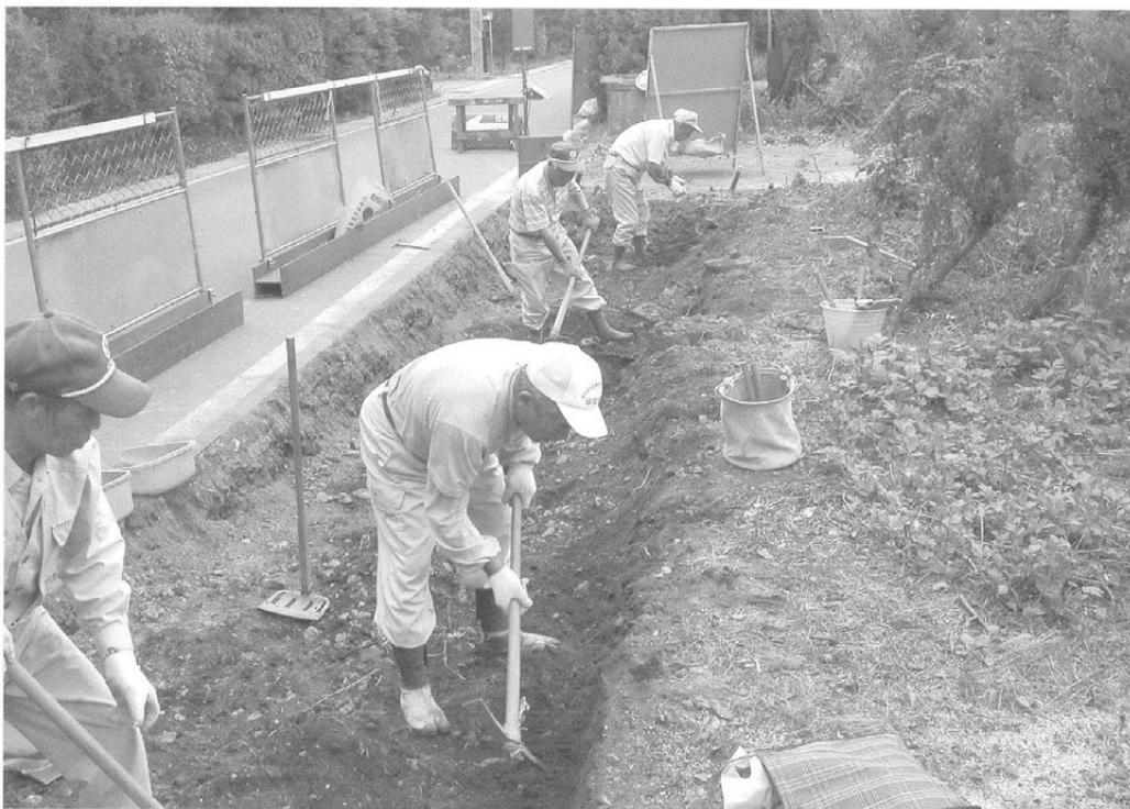
A区作業風景
