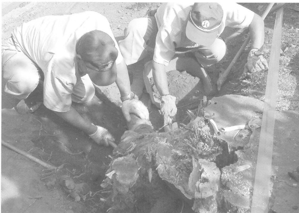
A区作業風景
