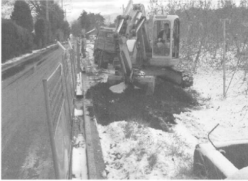
D区 重機による掘削
