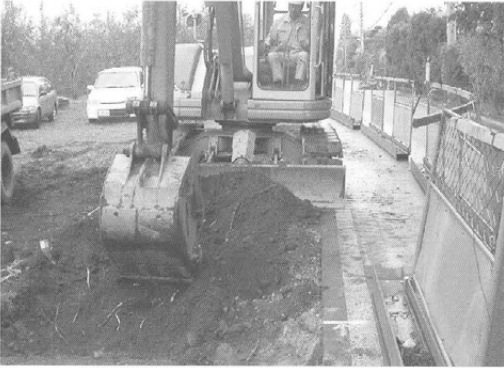
B区 重機による掘削
