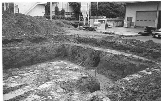
トレンチ検出状況（東より）
