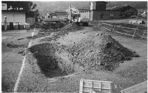
TP1検出状況 (南より)
