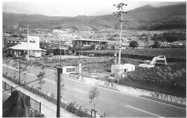
試掘トレンチ近景 (南西より)
