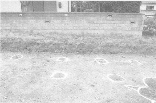
1号掘立柱建物址検出状況（北より）
