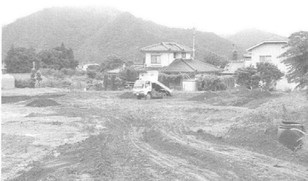
埋め戻し状況（北東より）
