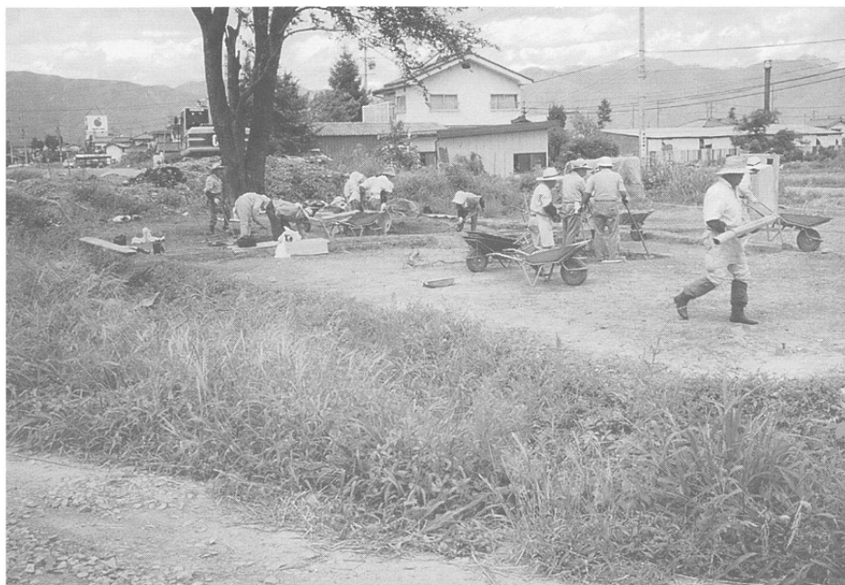
主郭部作業状況
