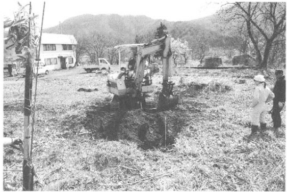
2. 表土除去（北西から）
