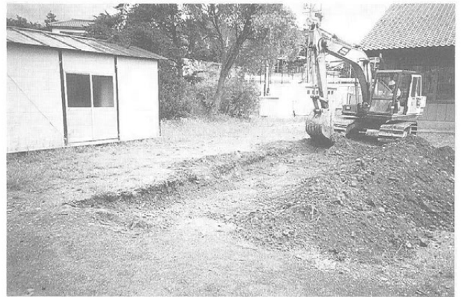
バックホーで表面の土を取り除いているところ
