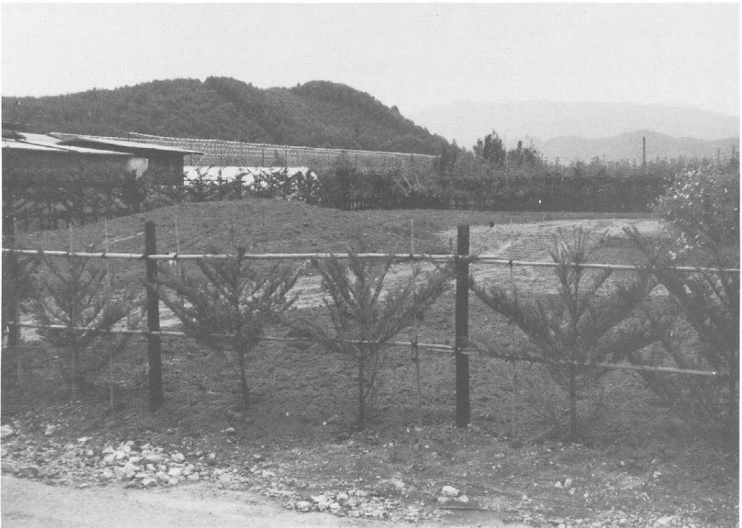
土盛り工事（築山部分）
