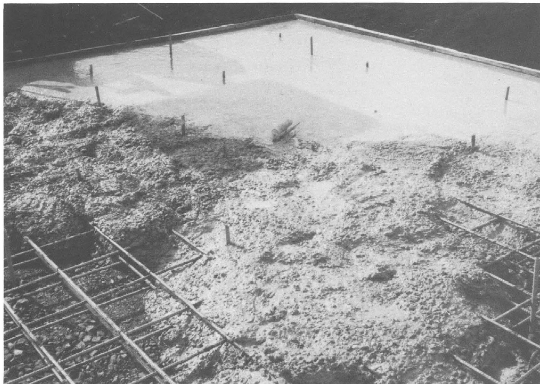
第 62 号復原住居基礎工事
