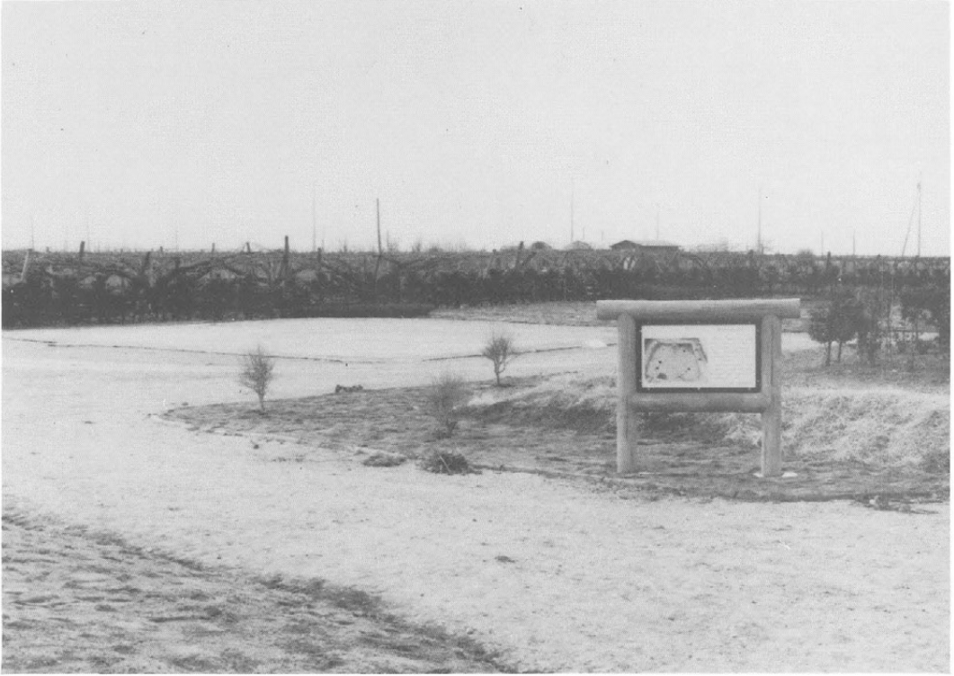
土盛り工事（遊歩道・有明砂舗装）
