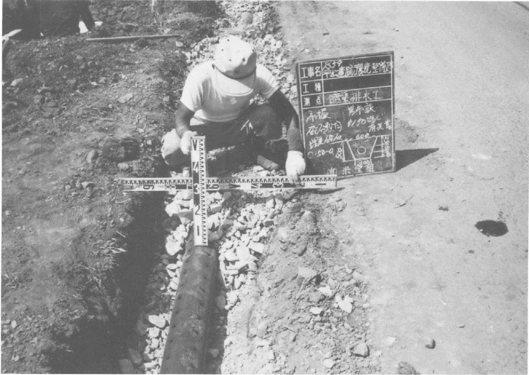
暗渠排水工事
