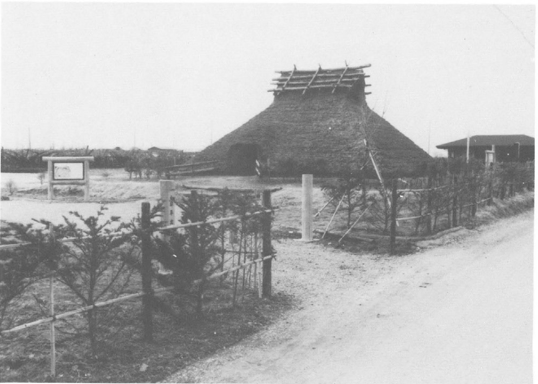
環境整備全景（南側入口より）
