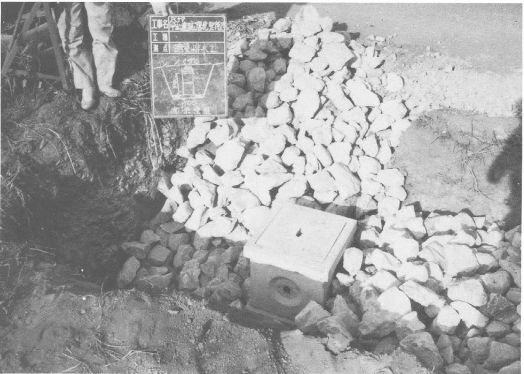
浸透樹設置工事
