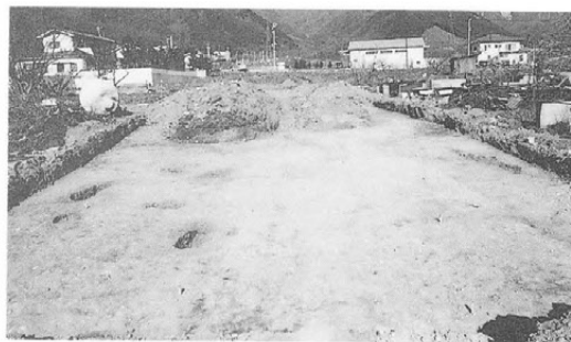
上町遺跡Ⅲ区全景（西より）
