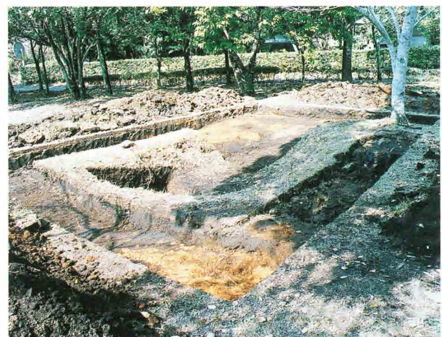
図版17 陥没部周辺トレンチ状況
