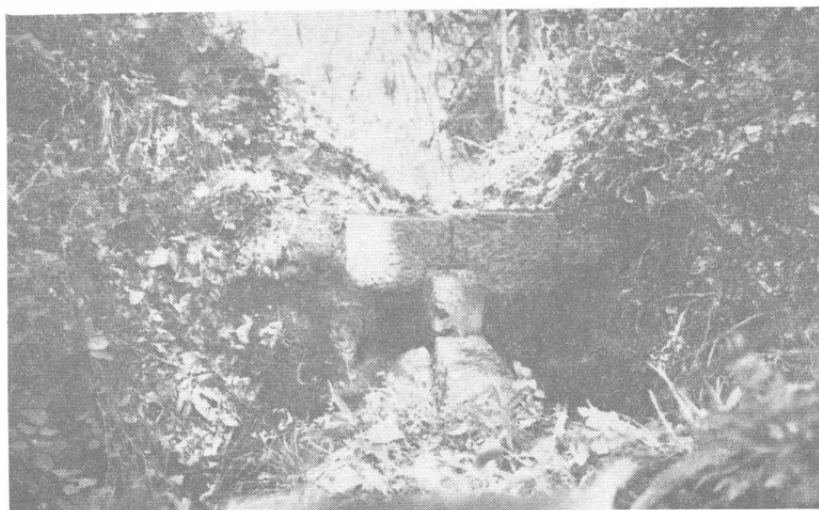
第 1 図 田上堰・鳴沢山分水口
