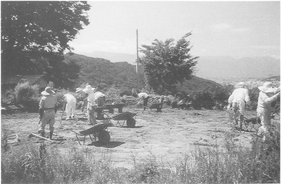
A 地区作業風景
