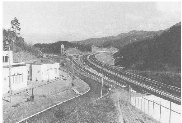
十二遺跡現況 (下り線筑北パーキングエリア)
