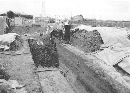
埋め戻し作業
