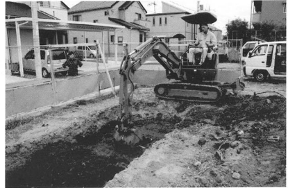
第1調査区埋め戻し作業(北西から)
