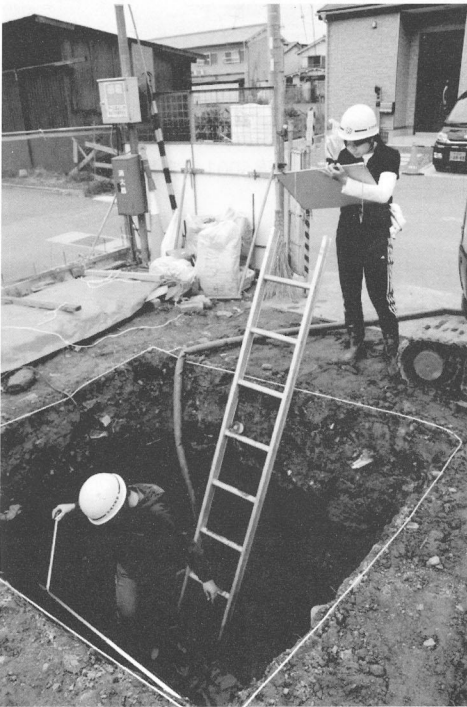
図面作成作業(南西から)
