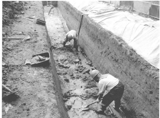
周濠内の礫石群検出作業(北から)
