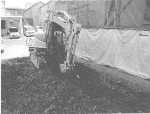
第3調査区掘削風景
