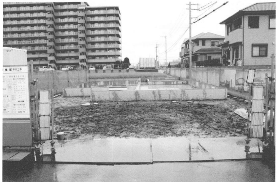
第2調査区埋め戻し後全景(東から)
