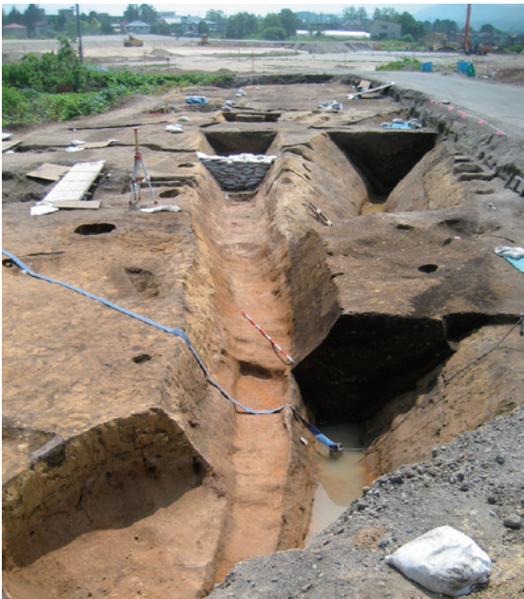
写真2-282 SD-019完掘 (NE→)
