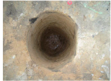
写真2-322 SP-1054完掘(S→)
