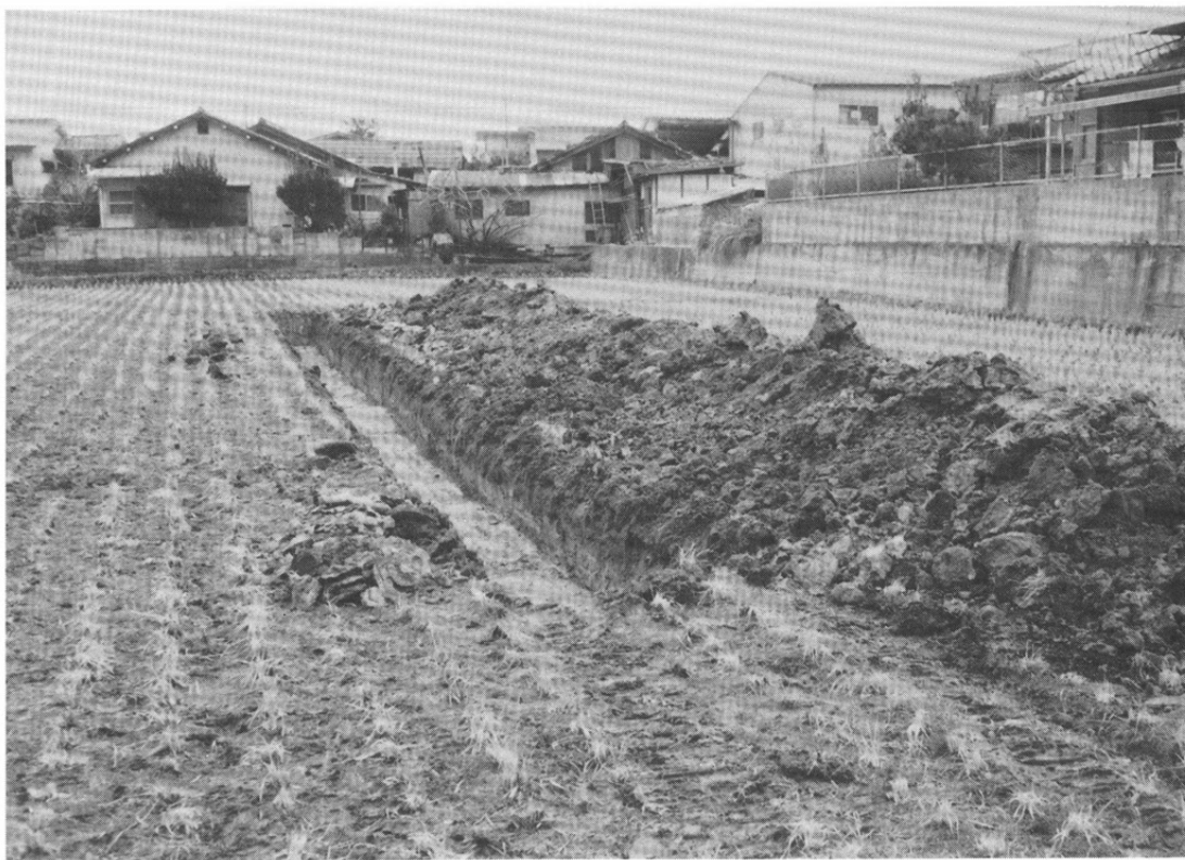
1. 調査地全景（東から）
