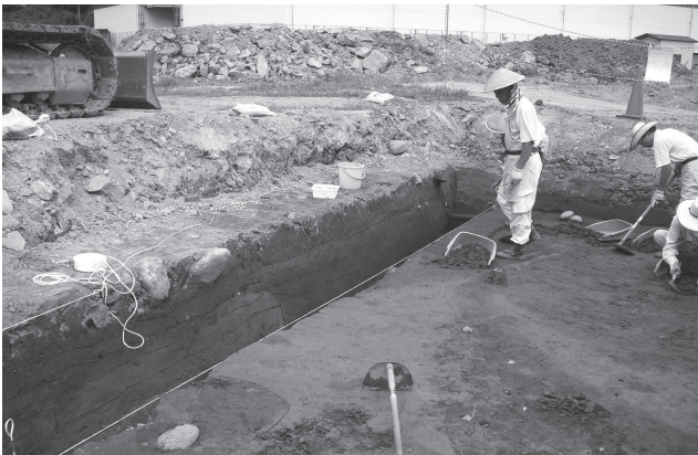
写真5：寺地東端を確認した様子（南西から）
