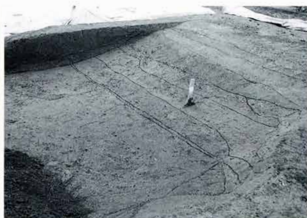
C72 (土塁) 盛土の状況
