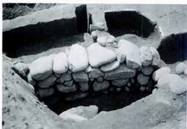
H108 (特殊土坑) 石積の様子 (あるいは完掘) (北から)
