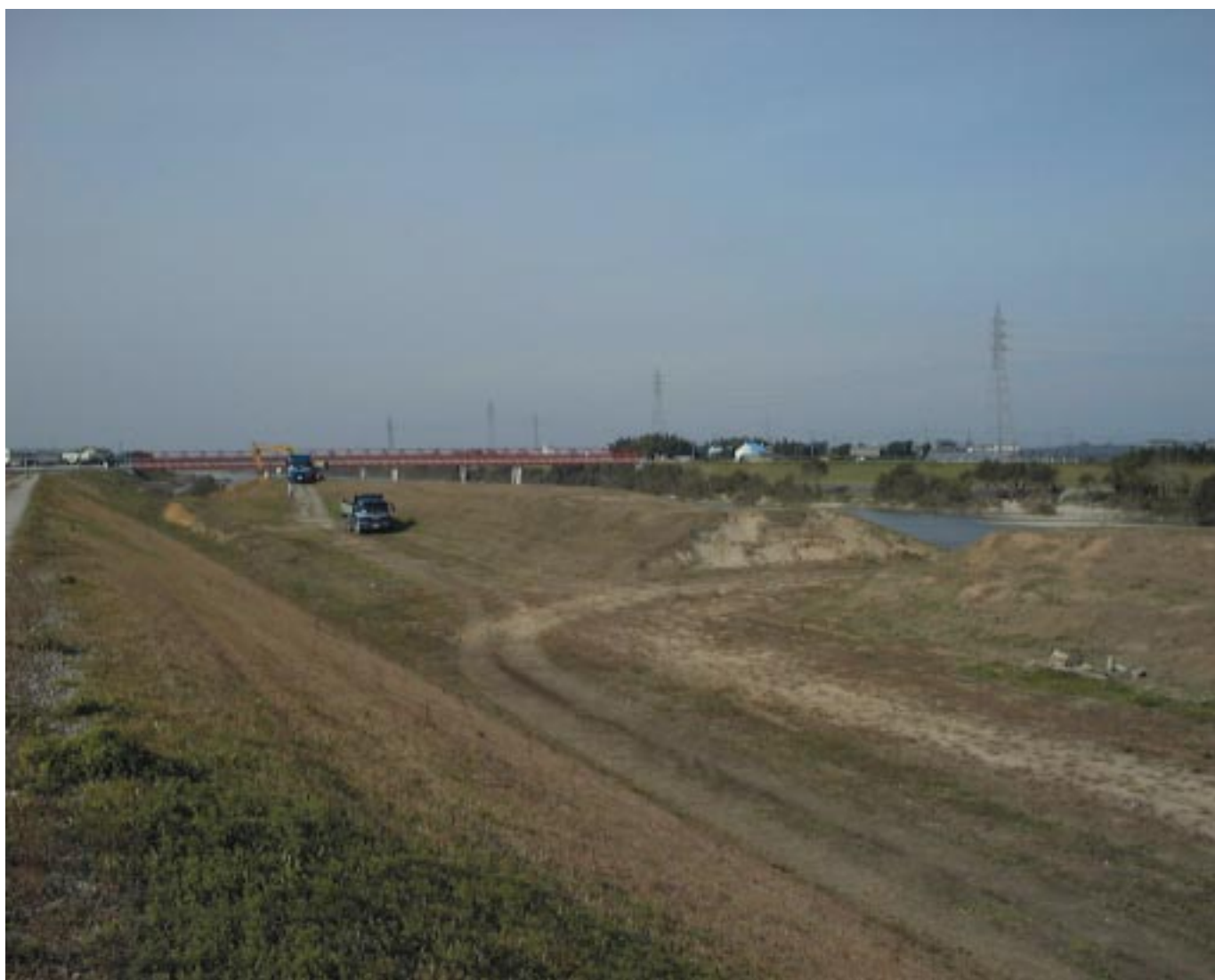
調査前風景（南東から）
