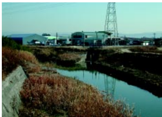
図25 木戸樋門(西から)
