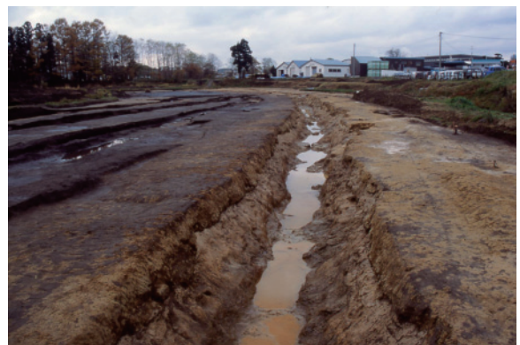
写真3-27 A・C区 SD-01完掘(E→)
