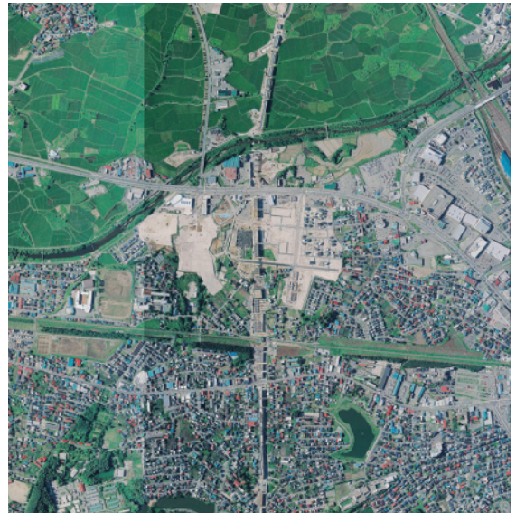
写真 1-11 平成 19 年時の土地区画整理事業予定地の状況
