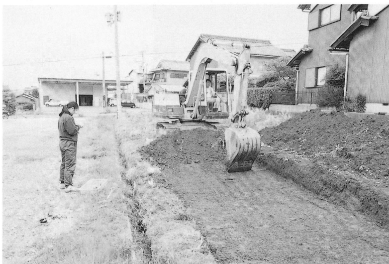
南トレンチ 掘削風景 (南から)
