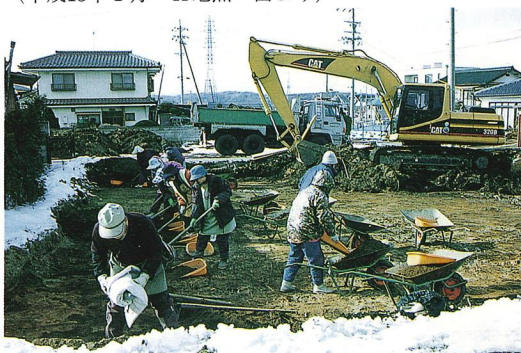
(平成13年1月 I地点 東より)
