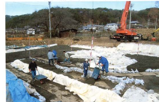
人力と重機による埋め戻し作業
