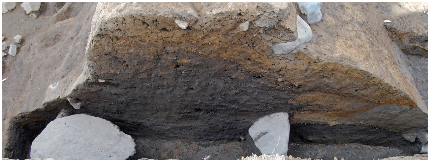
2A1 トレンチ 土塁盛土断面（東から）
