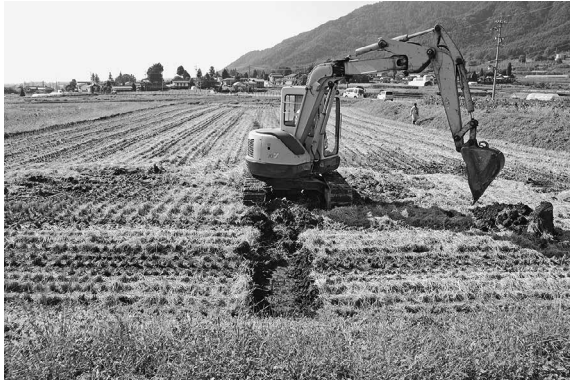
調査状況（北から）
