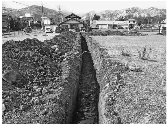
Aトレンチ (東から)
