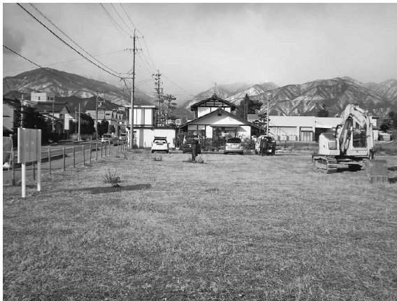
調査地全景 (東から)
