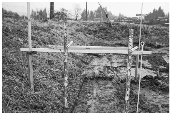
盛土施工確認
