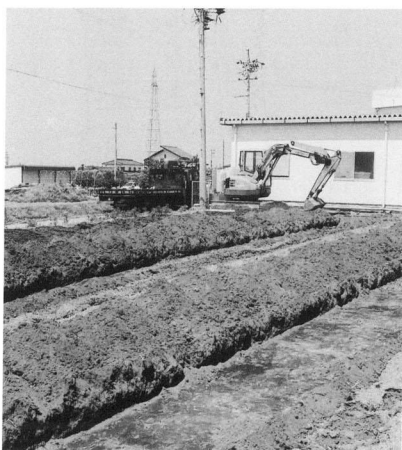
試掘トレンチ
