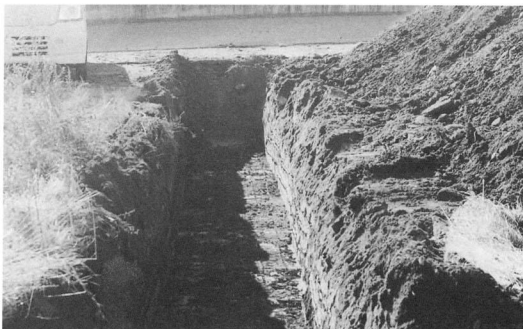
試掘トレンチ
