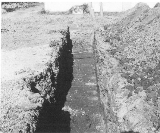
試掘トレンチ
