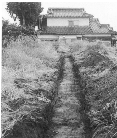
試掘トレンチ
