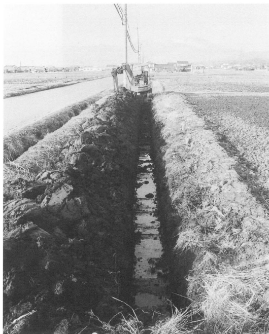
試掘トレンチ
