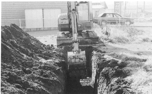
試掘トレンチ
