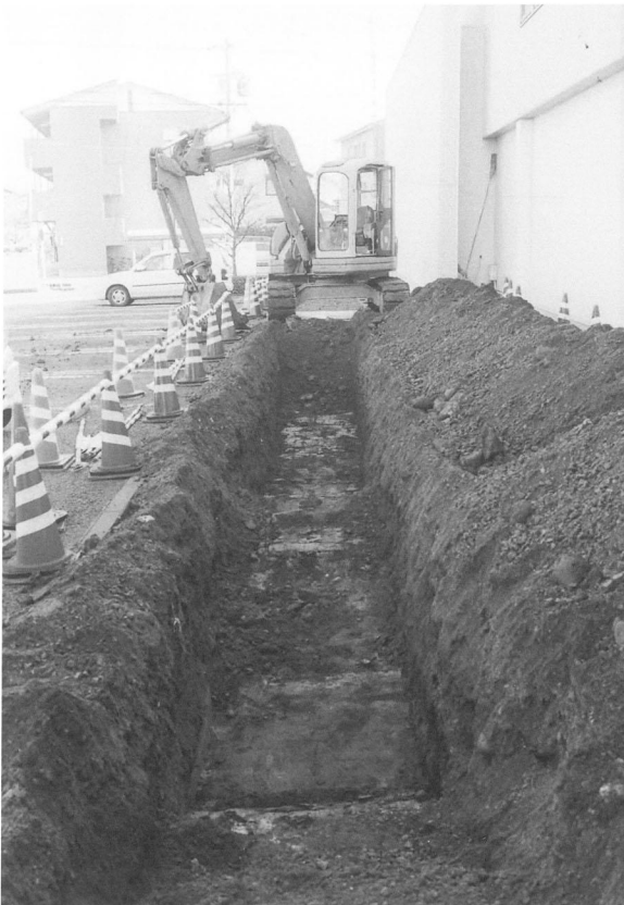
試掘トレンチ
