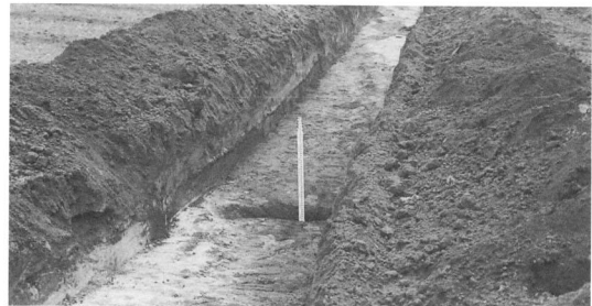
暗渠検出状況
