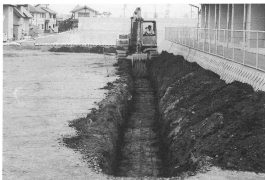
試掘トレンチ
