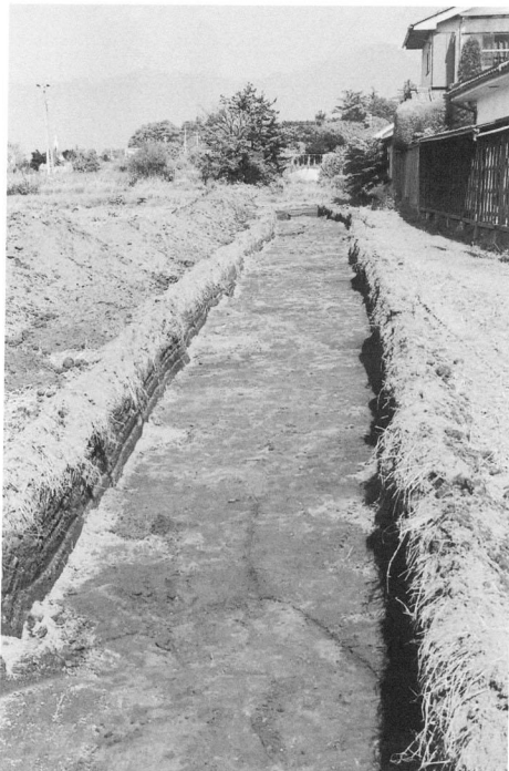
試掘トレンチ
