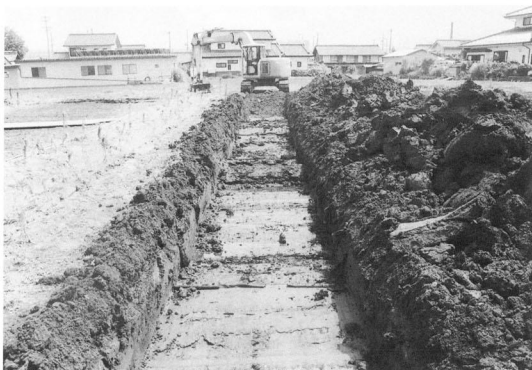
試掘トレンチ
