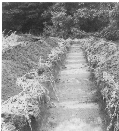
試掘トレンチ
