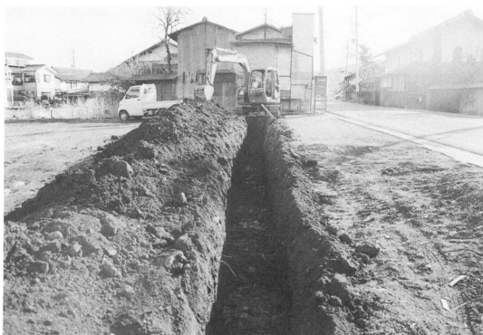
試掘トレンチ
