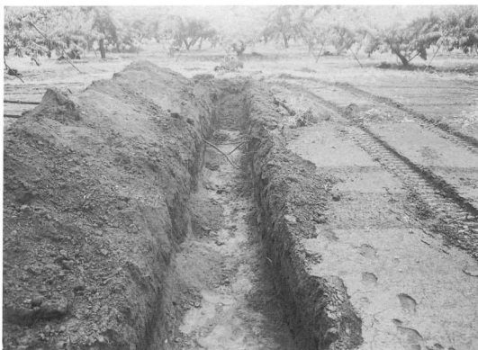
試掘トレンチ
