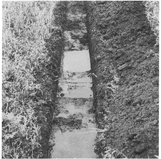
試掘トレンチ
