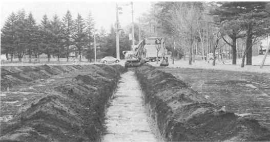
試掘トレンチ
