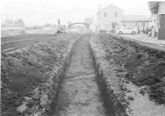
試掘トレンチ
