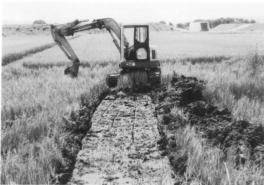
試掘トレンチ
