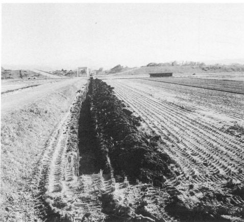
試掘トレンチ
