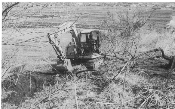
試掘トレンチ
