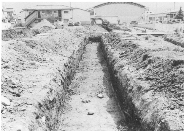
試掘トレンチ
