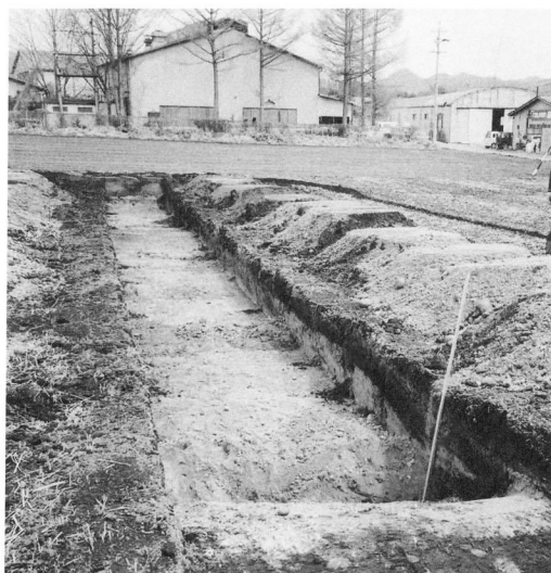
試掘トレンチ
