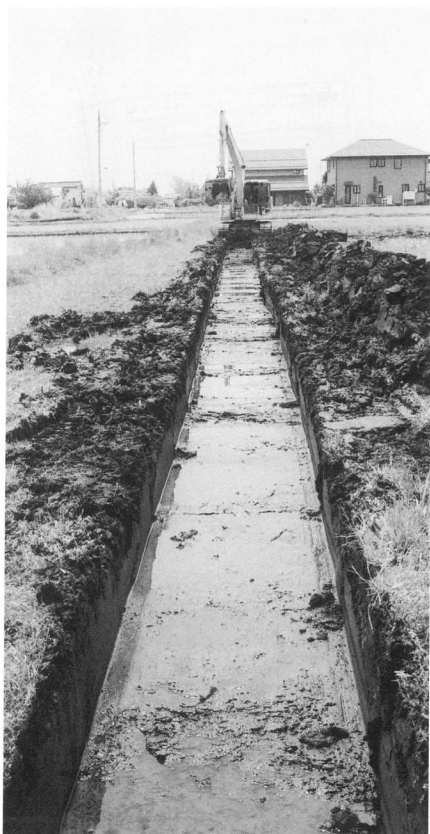
試掘トレンチ
