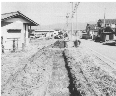
試掘トレンチ
