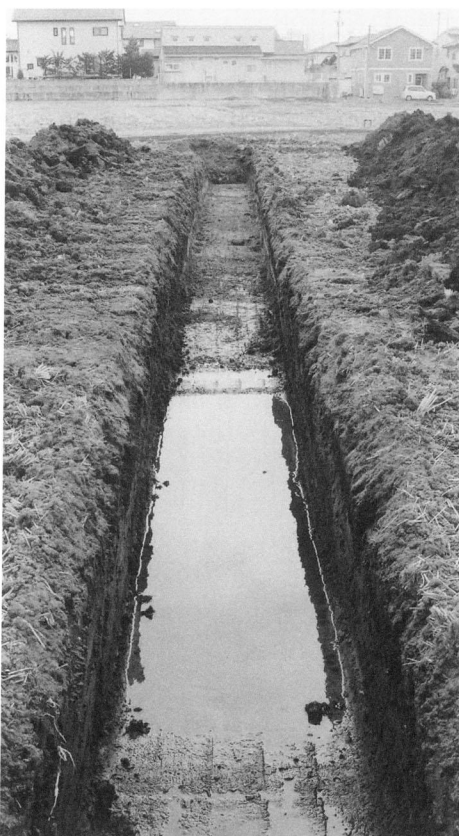
試掘トレンチ
