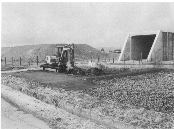
試掘トレンチ
