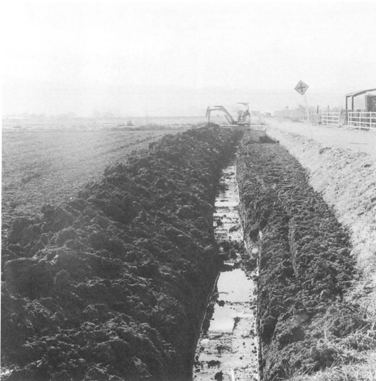
試掘トレンチ
