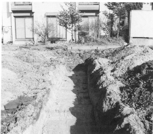
試掘トレンチ
