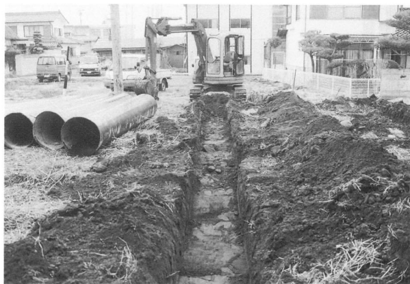
試掘トレンチ
