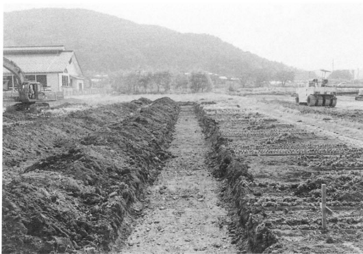
試掘トレンチ
