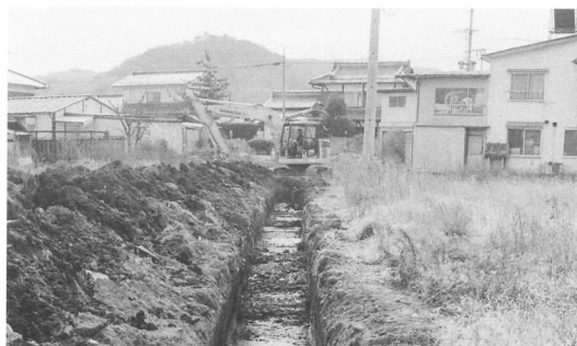
試掘トレンチ
