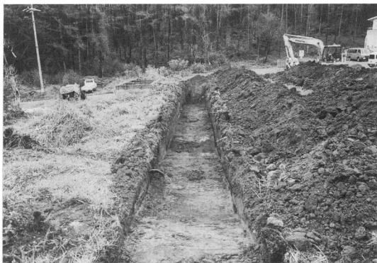
試掘トレンチ
