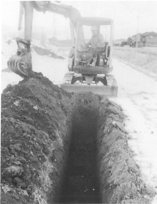
試掘トレンチ
