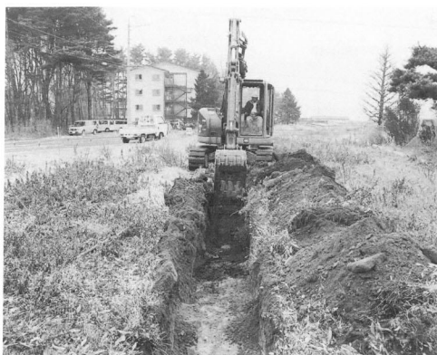
試掘トレンチ
