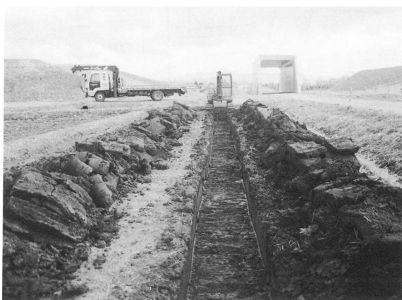
試掘トレンチ
