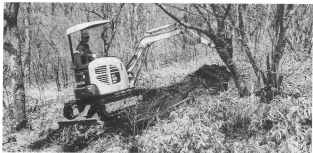
試掘トレンチ
