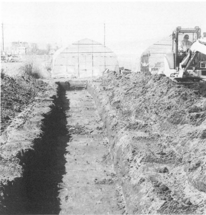
試掘トレンチ
