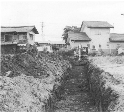
試掘トレンチ
