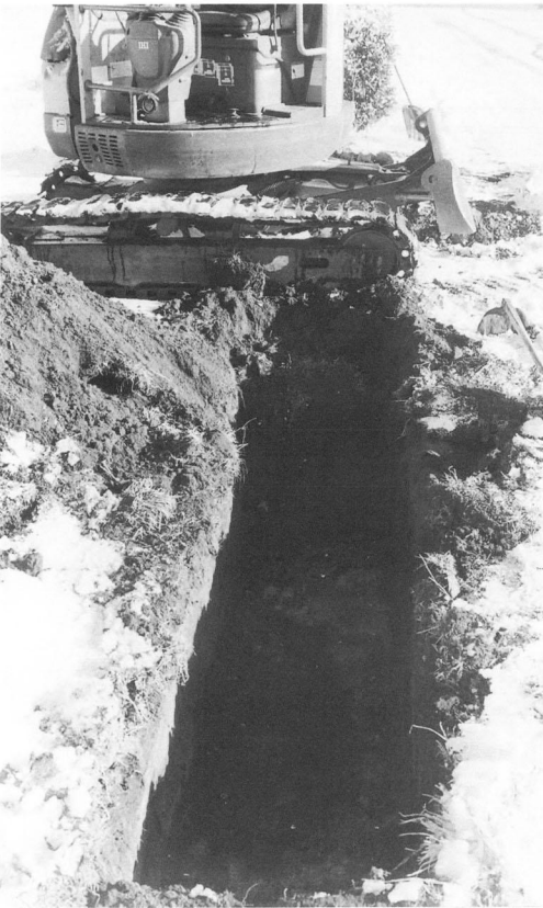
試掘トレンチ
