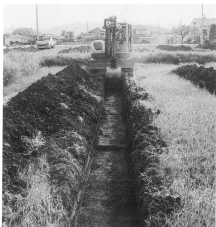
試掘トレンチ
