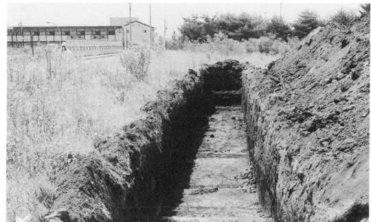
試掘トレンチ
