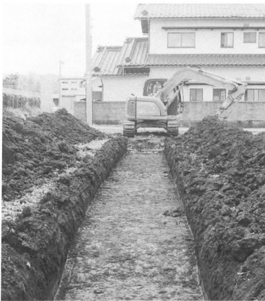
試掘トレンチ
