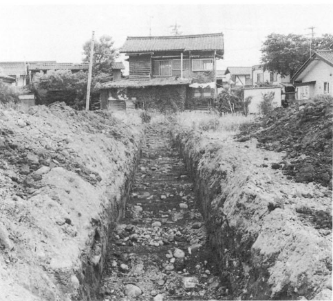
試掘トレンチ
