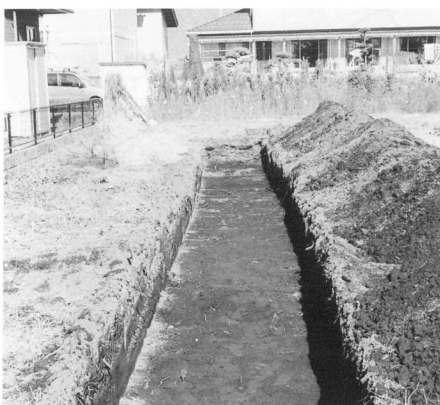
試掘トレンチ
