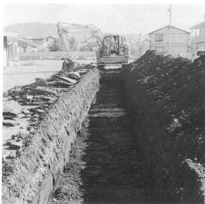
試掘トレンチ
