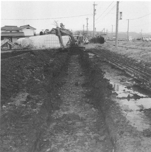
試掘トレンチ
