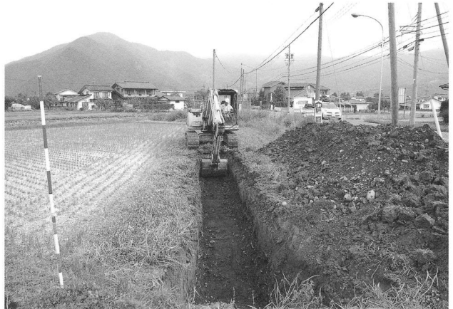
1号トレンチ掘削状況 (南西より)
