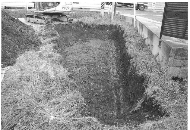
トレンチ検出状況（南より）
