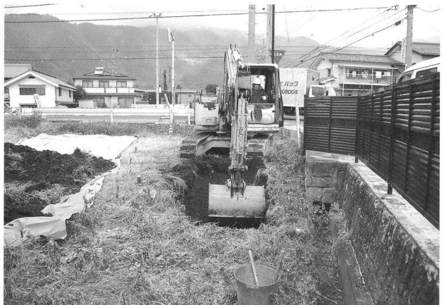
トレンチ掘削状況（南より）
