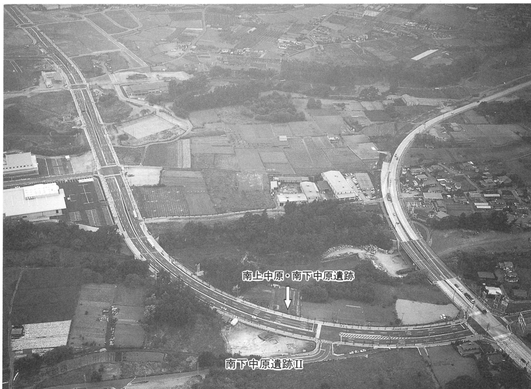
南下中原遺跡IIと南上中原・南下中原遺跡
