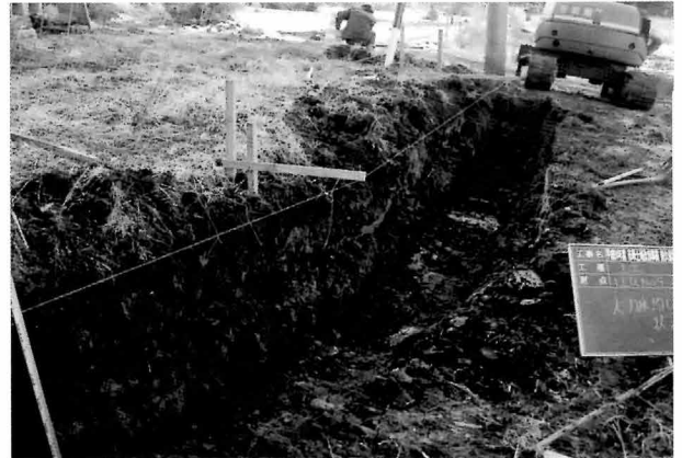
掘削・堆積状況
