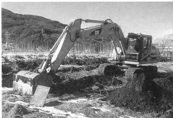
①平成14年度試掘調査の表土剥ぎ
