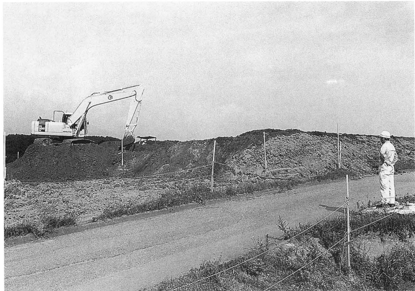
②同盛土作業
