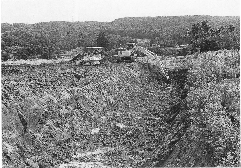
①平成17年度本工事の遺跡保存地用ロームの切出し
