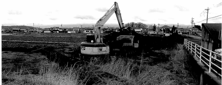
作業風景 (表土掘削)→
