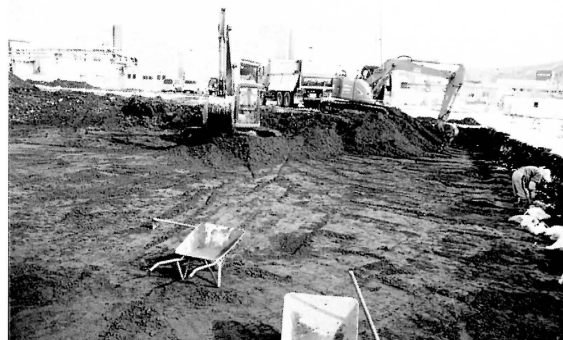
バックホーによる表土掘削
