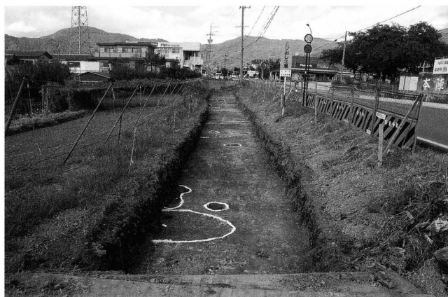
完掘状況 (南より)
