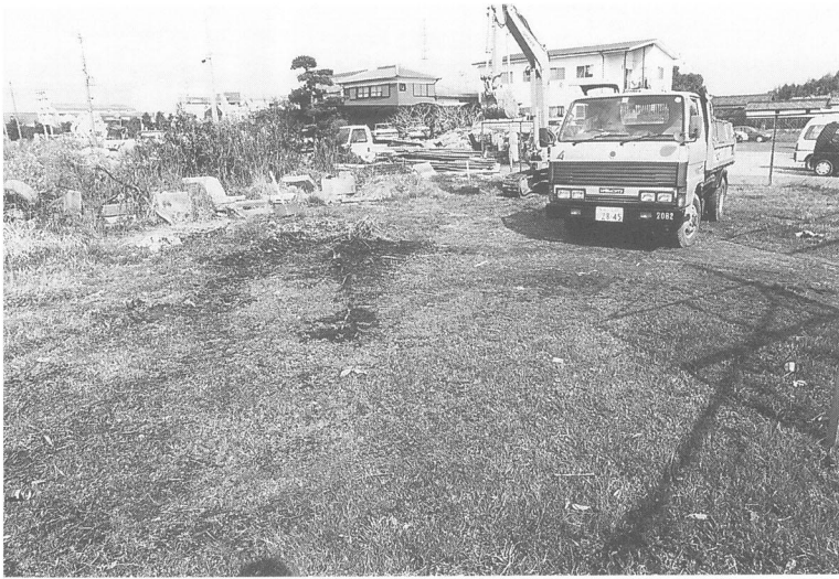
写真19 第7次調査調査前全景 (南東から)
