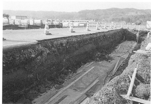
C 地点西側立会状況（東より）
