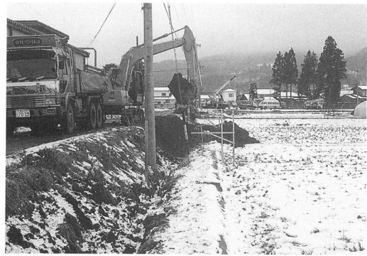
A 地点立会試掘状況（北より）
