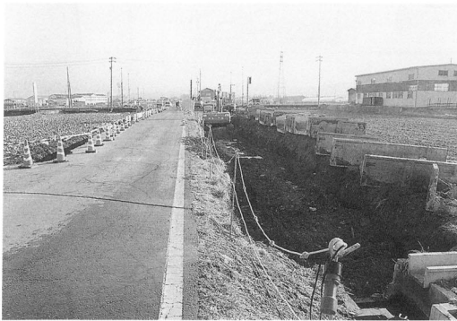
C 地点西側立会状況（西より）
