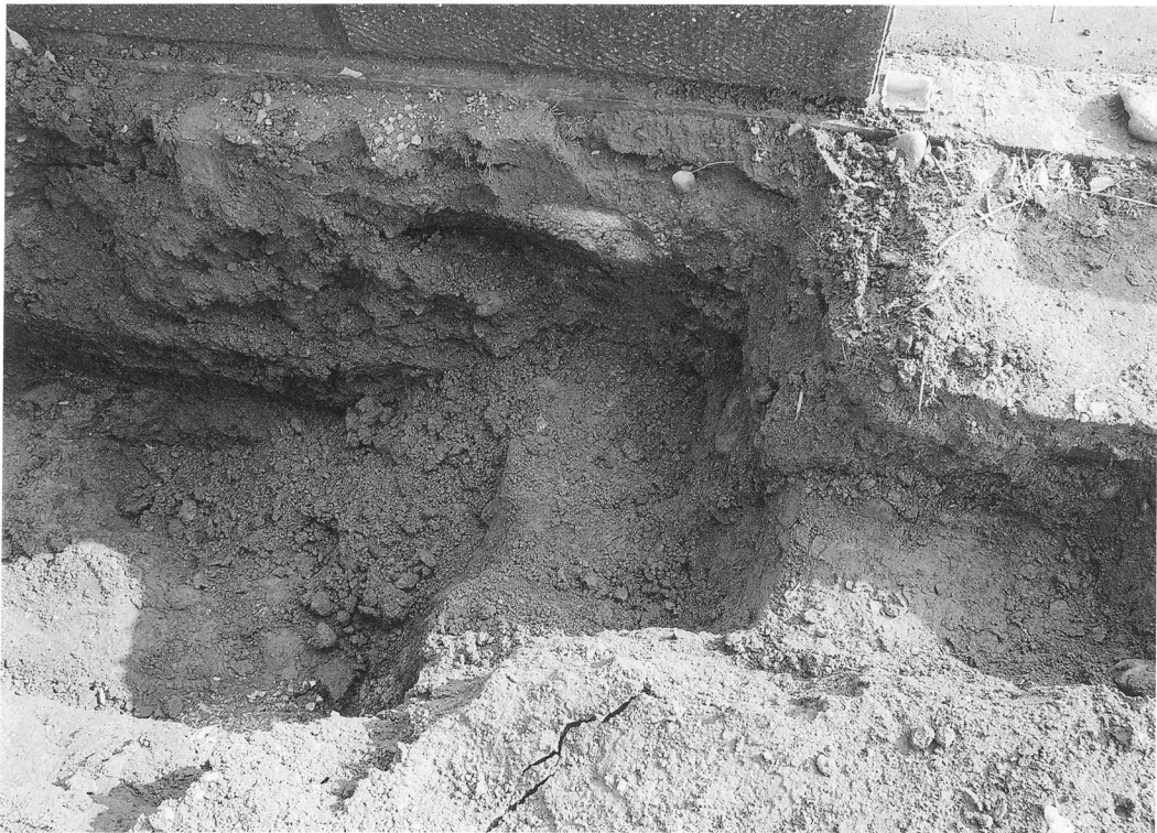
常光院塚 トレンチ掘削状況（西より）
