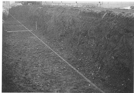
A 地点立会状況（南より）
