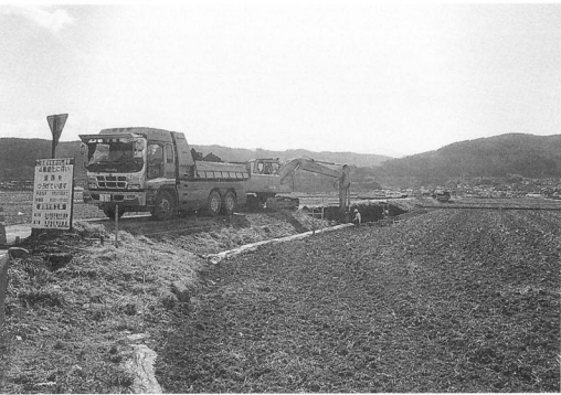
E 地点西側立会状況（東より）
