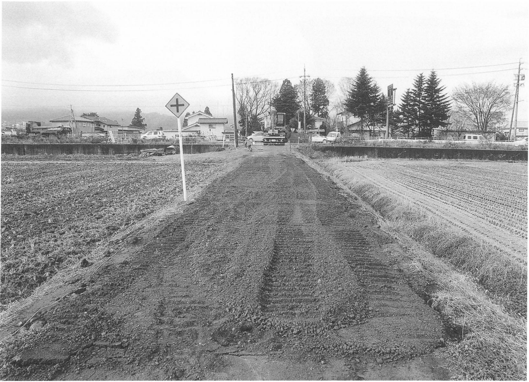
市道遺跡Ⅳ 道路復旧状況（東より）
