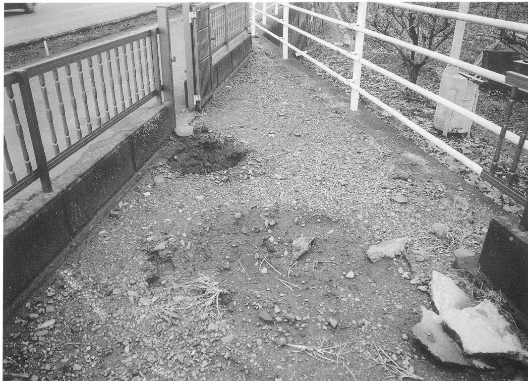
常光院塚 石碑と丸石の撤去状況（北より）
