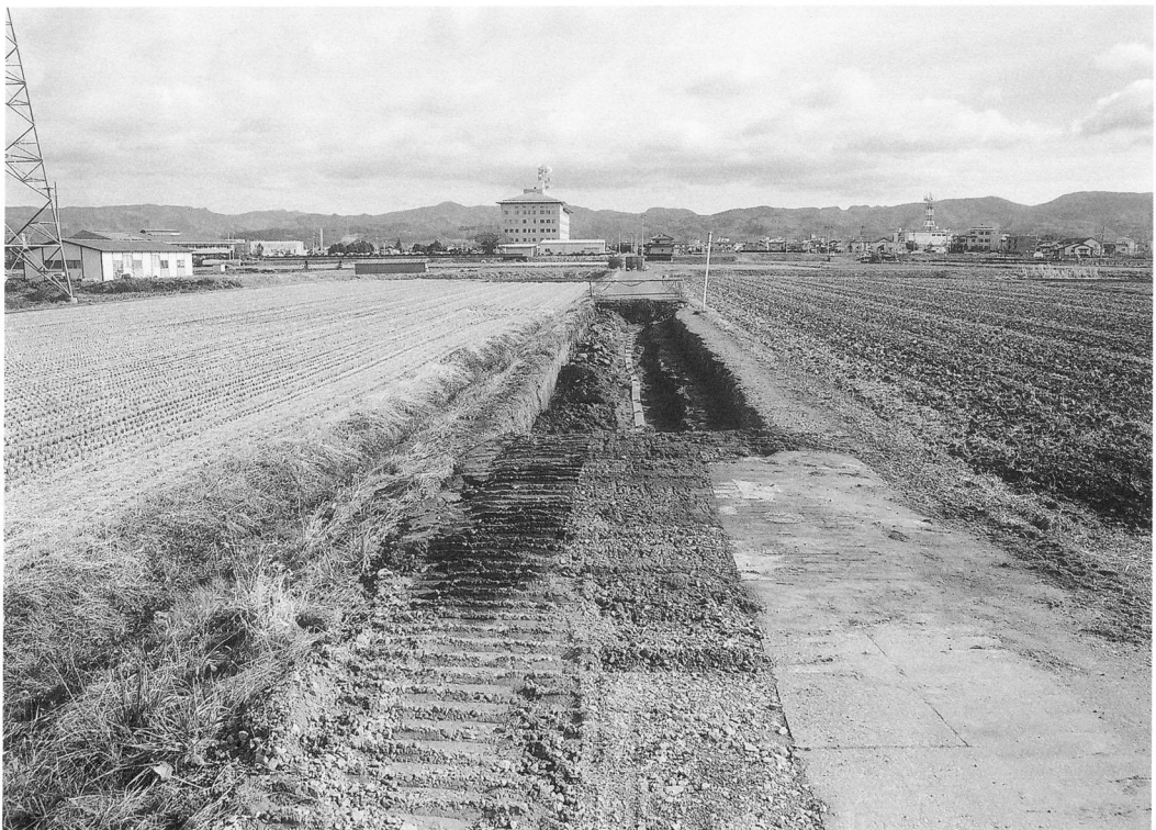
市道遺跡Ⅳ 埋め戻し状況（西より、中央ガス埋設管）
