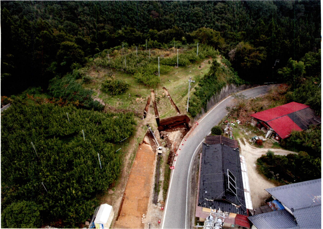
1. 曲輪 2、堀切 1 の発掘調査（堀切 2 上空から曲輪 2、堀切 1、主郭を見る）平成 22 年 10 月撮影
