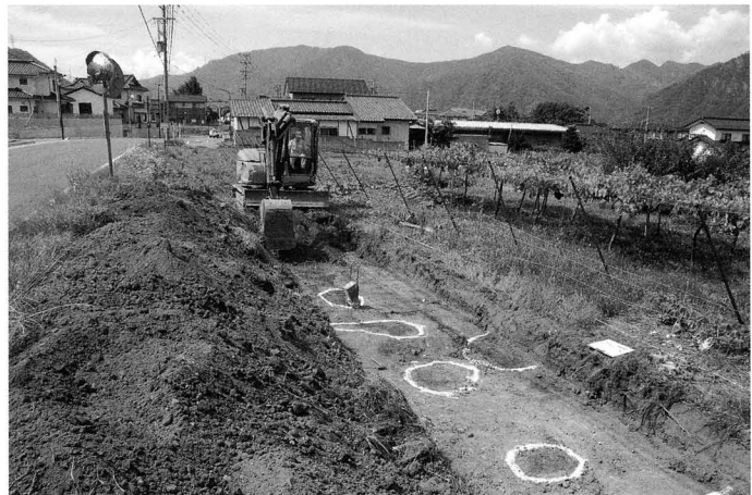
トレンチ掘削状況 (北より)
