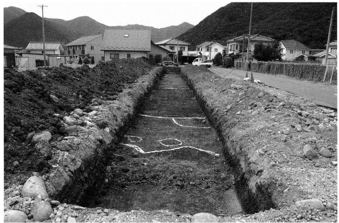
1号トレンチ検出状況 (東より)
