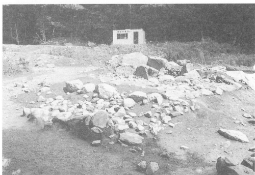
写真56 西側外護列石と崩落礫（南西から）
