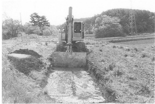
写真1 重機でトレンチを掘る
