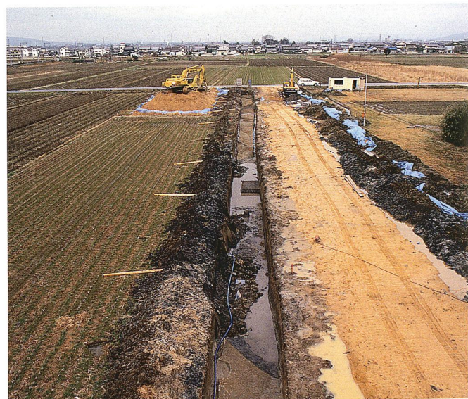
写真7 第1トレンチ完掘状況(南から)
