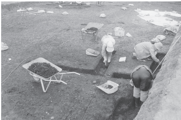
左：8区作業風景 (西より)
