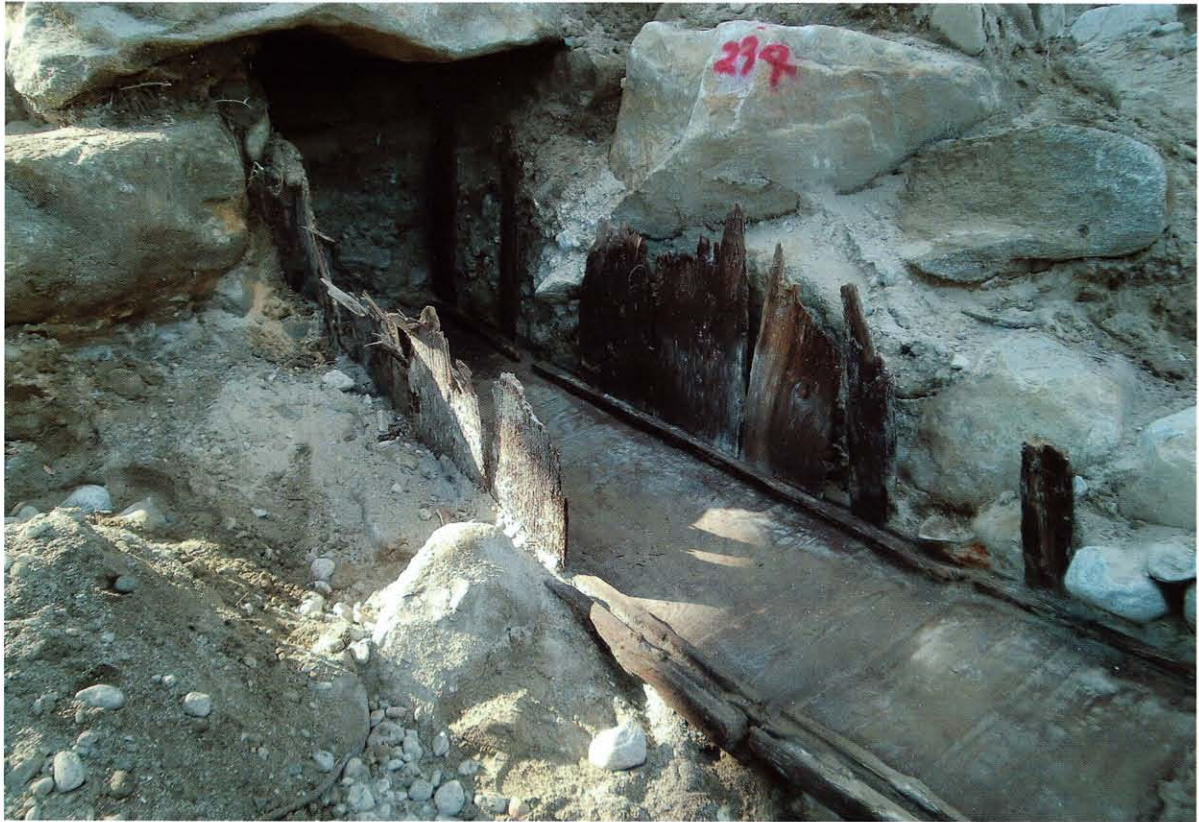
(1) 灌溉用水路 入口木樋細部
