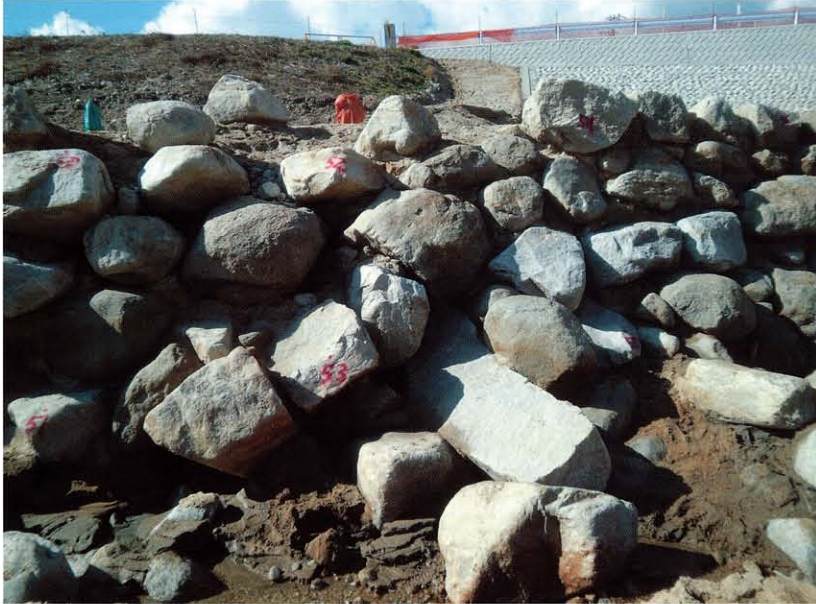
(1) B・D堤防接続部 川表側石積み(東→)
