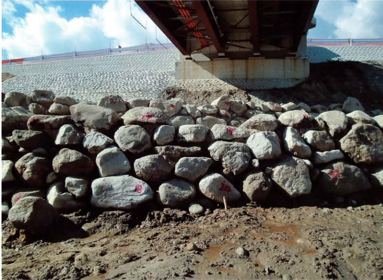
(1) A堤防 川表側石積み (東→)
