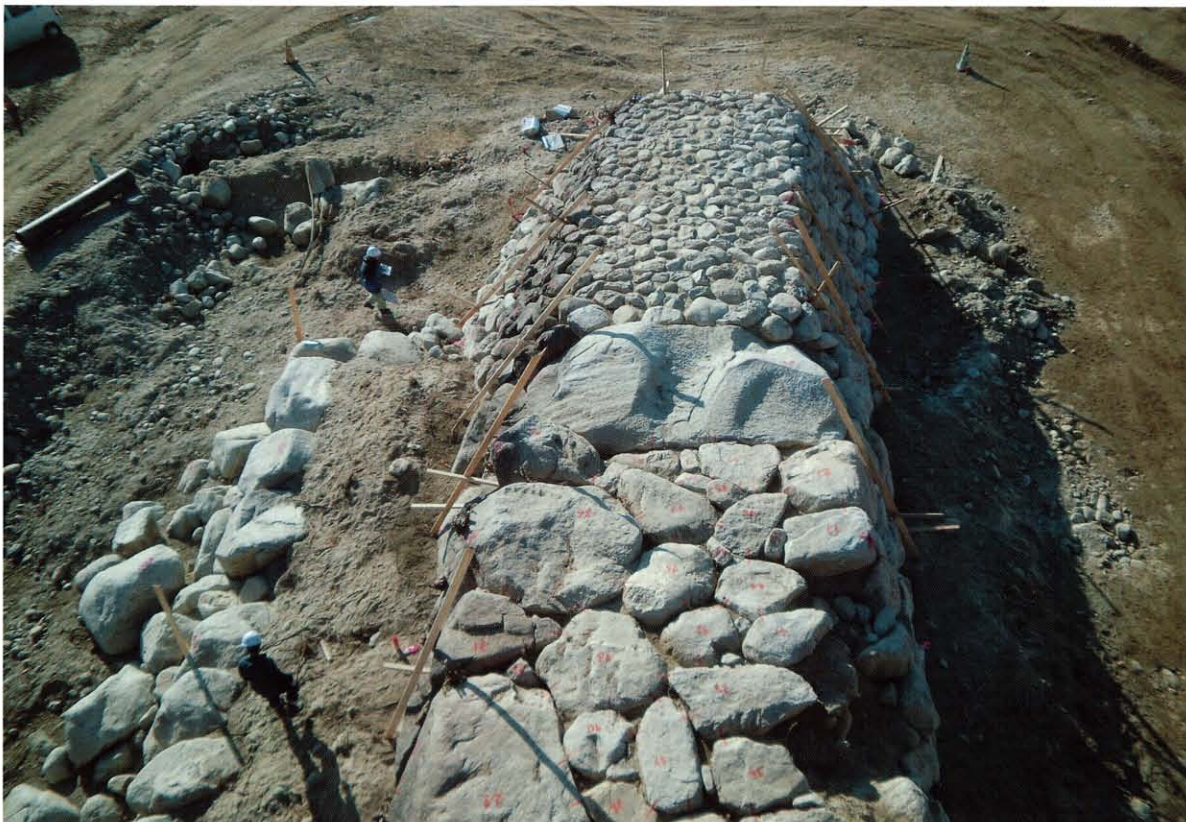
(1) C堤防下流部 増築部の馬踏
