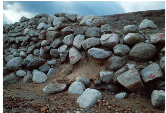
(4) B・D堤防灌漑水路入口推定場所
