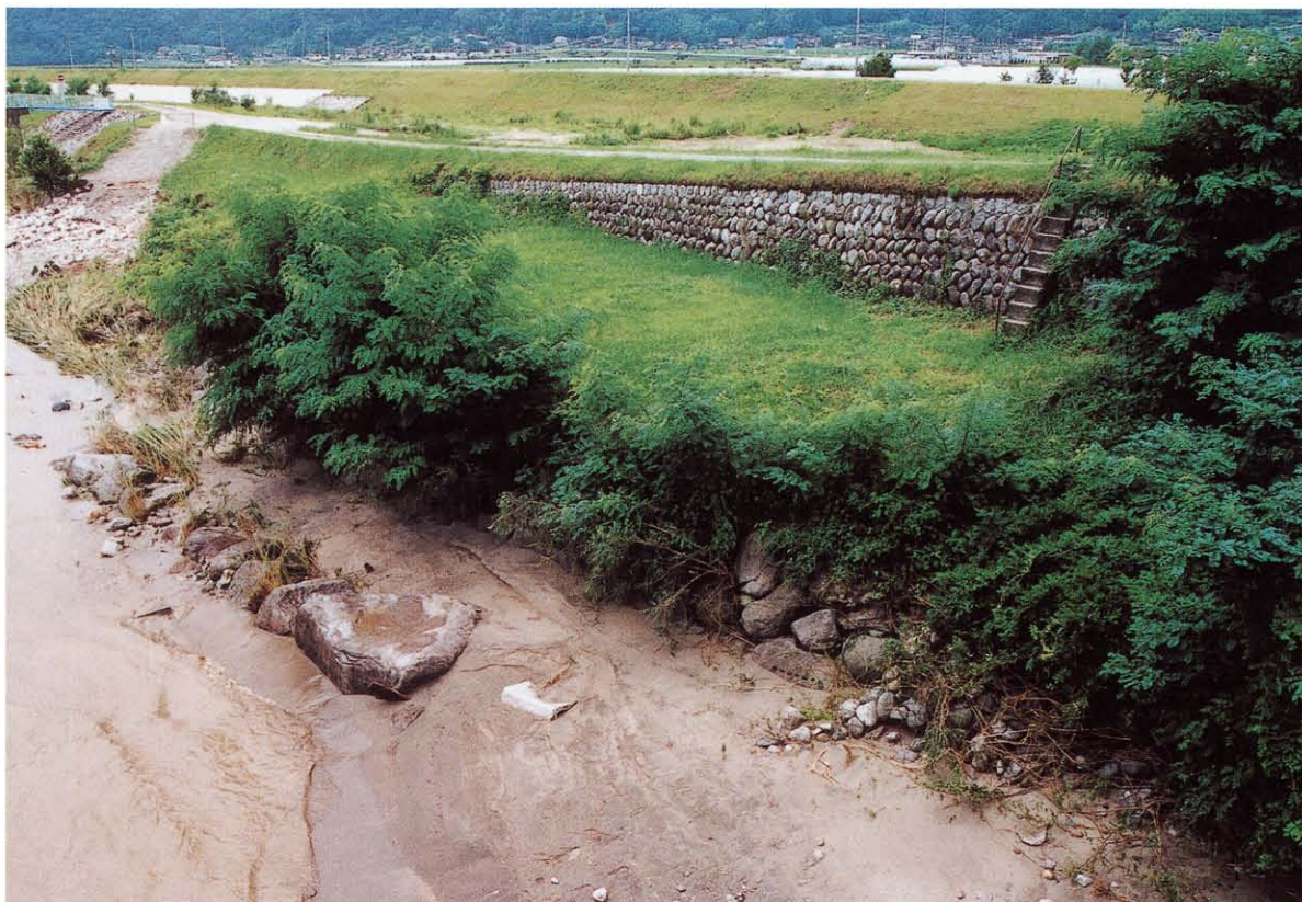
(1) 理兵衛堤防遠景、平成18年（調査前、東→）
