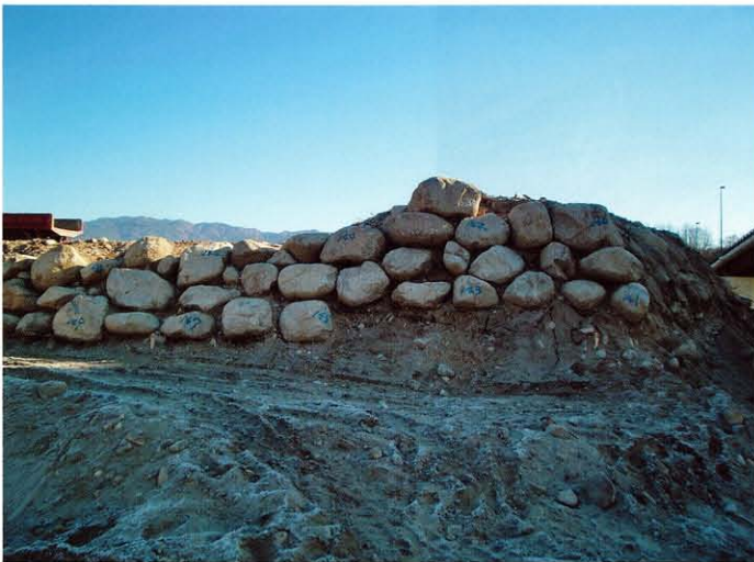
(3) C堤防中間部 川裏側石積み (西→)
