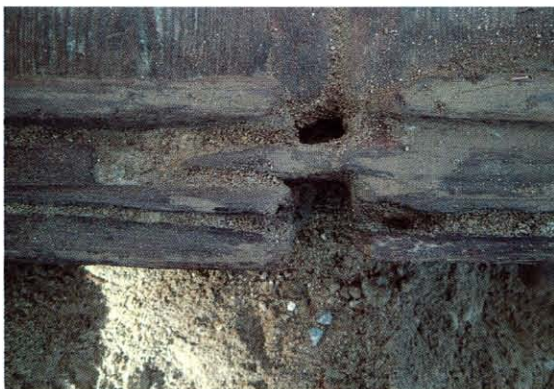
(7) 灌漑水路 豎土台継ぎ手細部
