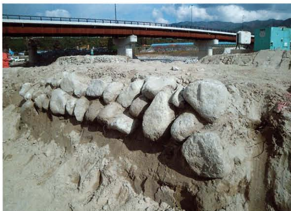
(3) D堤防 川裏側石積み(南西→)
