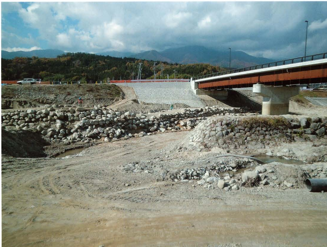
(1) B・D・C堤防 川表側石積み (南東→)
