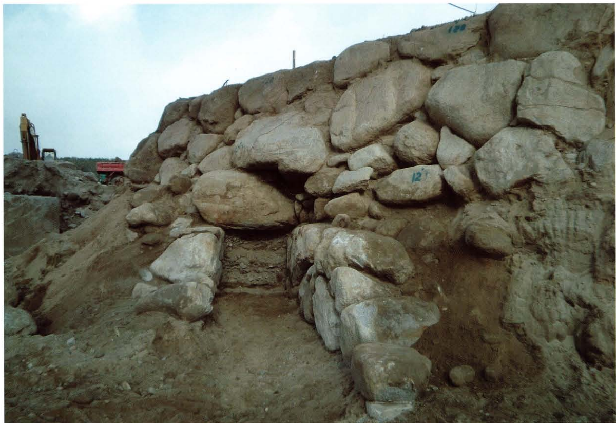
(2) 灌溉用水路 出口付近 (南西→)
