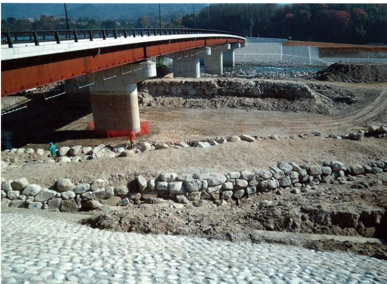
(2) B堤防 川裏側石積みと馬踏 (北西→)
