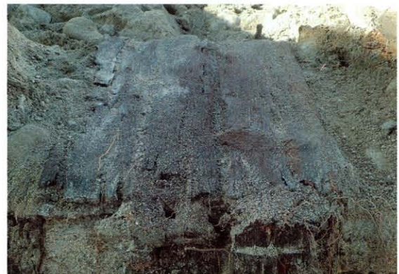
(6) 灌漑水路 堤体内部の甲蓋板
