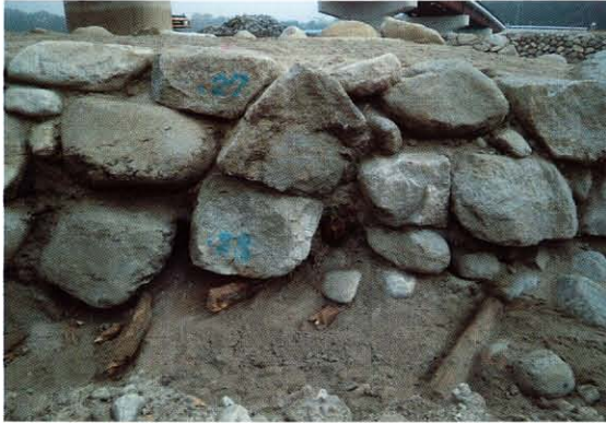
(1) B堤防川裏側丸太確認状況（年代測定実施）
