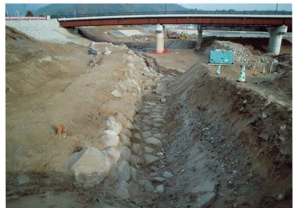
(4) D堤防 馬路と小段(南→)
