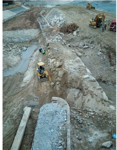
(2) C堤防中間部と上流側 (南→)
