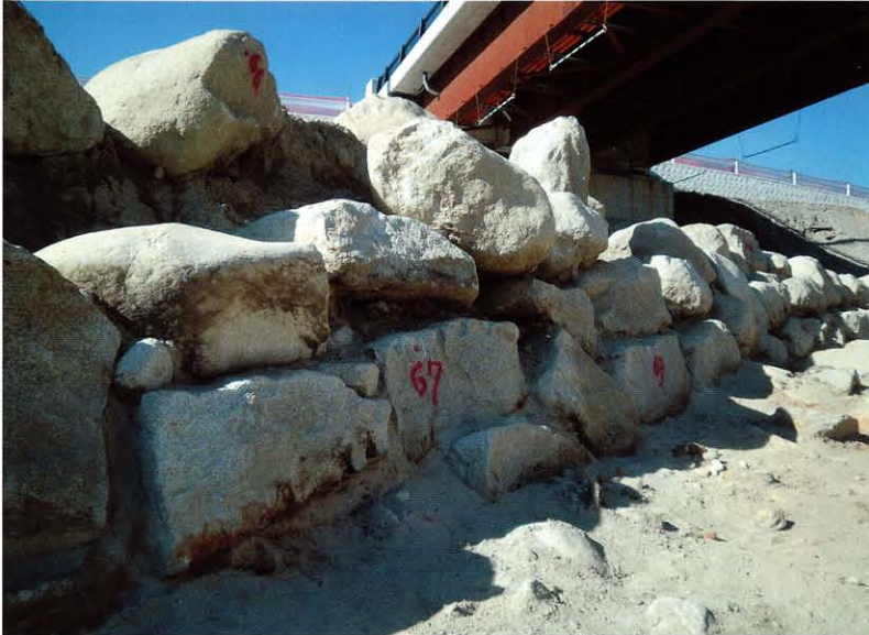
(1) B堤防 川表側石積み (南→)
