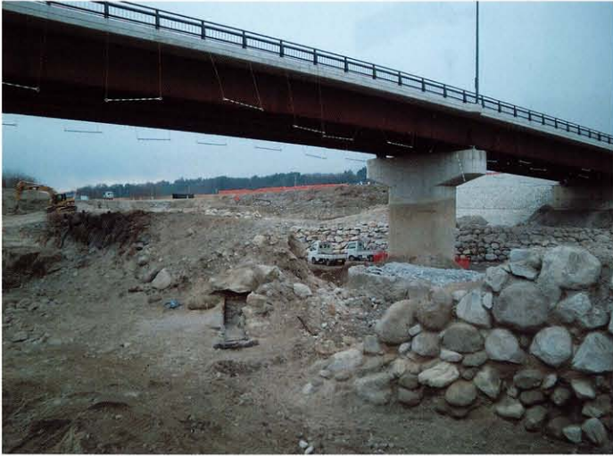
(1) C堤防中間部 川表側石積み (北東→)
