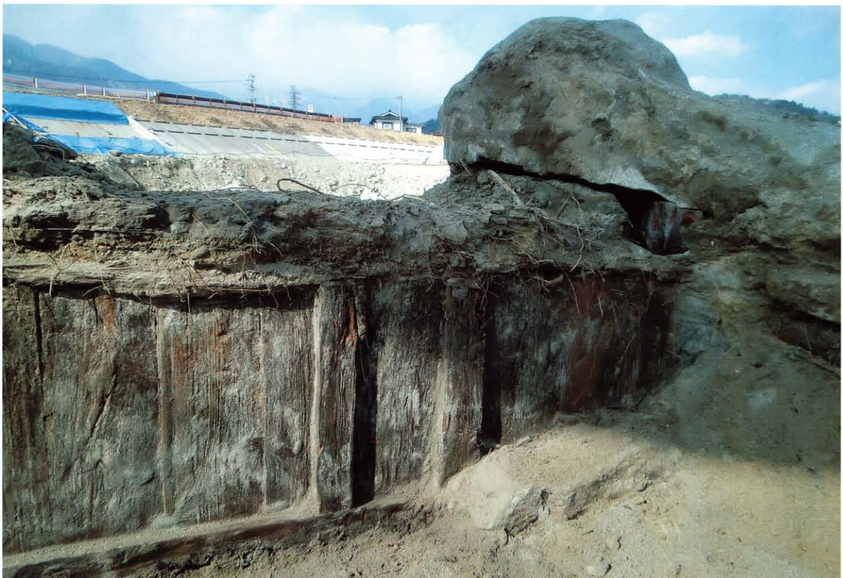
(2) 灌溉用水路 堤体内部の木樋細部
