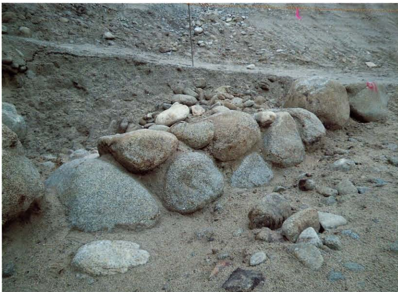
(2) A堤防 馬踏北側の配石 (南→)
