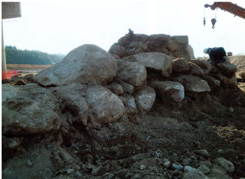
(1) 堤体内部の灌漑用水路の石組 (南→)
