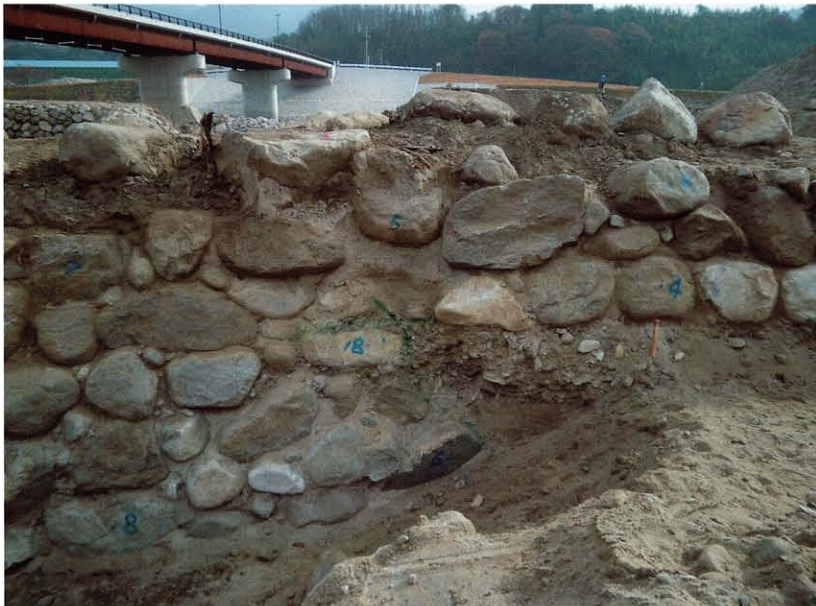
(2) B・D堤防接続部 川裏側石積み(西→)
