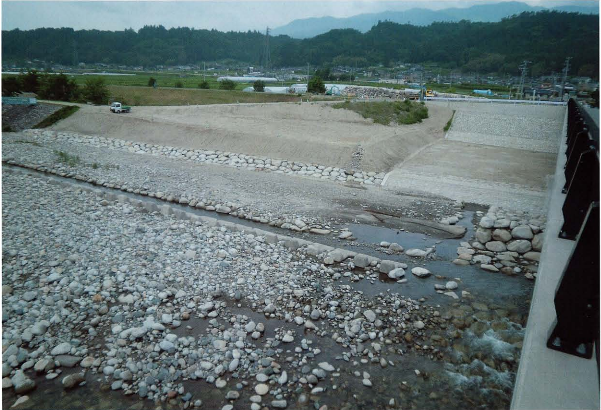
(1) 理兵衛堤防遠景（工事完了、東→）
