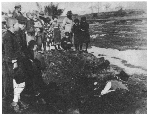
写真3 A号地点の調査風景
