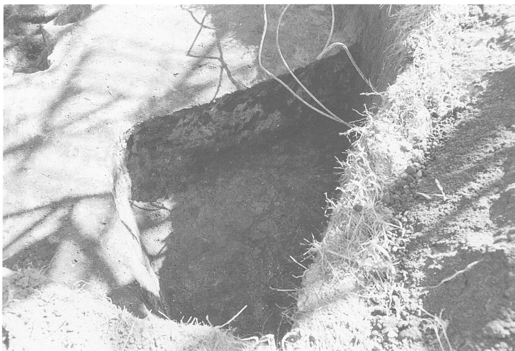
1 下曾根遺跡 I H 1 号住居址全景（北方から）
