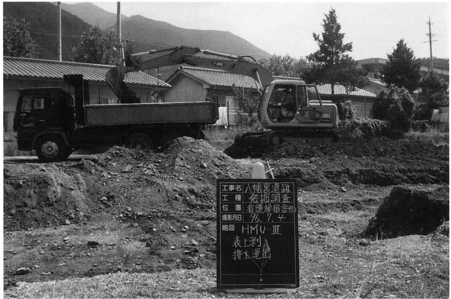
重機による表土剥 ～運搬
