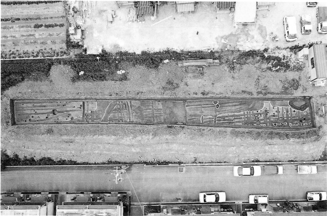
調査地全景（上が北）
