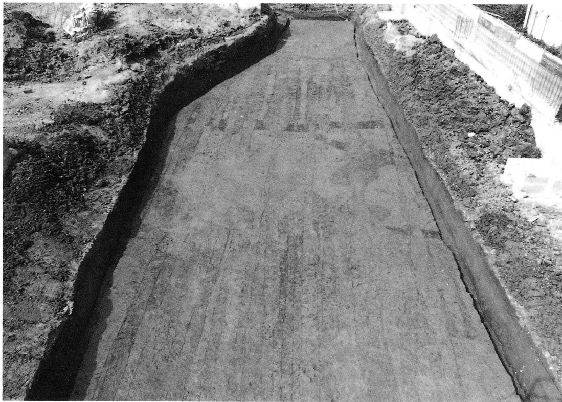
遺構検出状況(南から)
