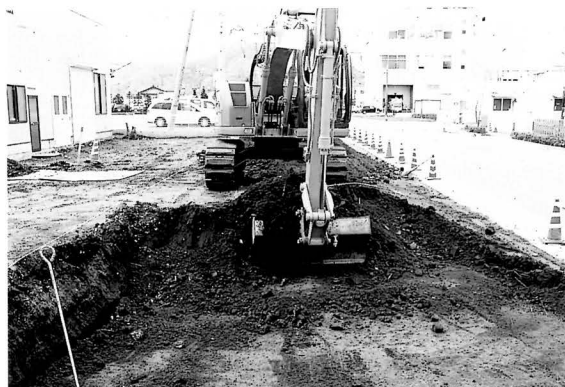
バックホーによる表土掘削(東1区)
