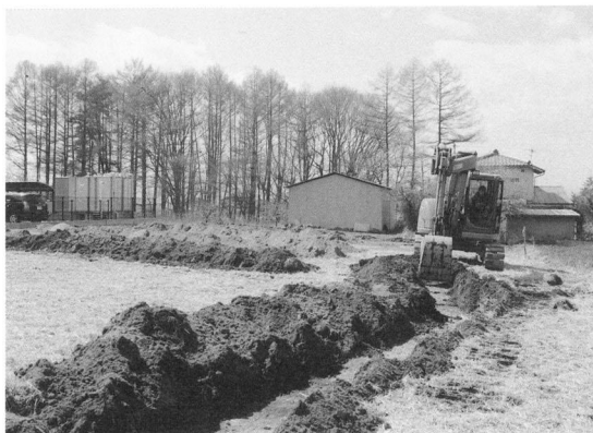
試掘トレンチ
