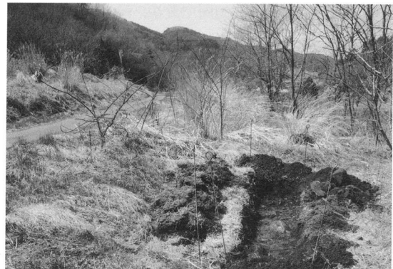
試掘トレンチ
