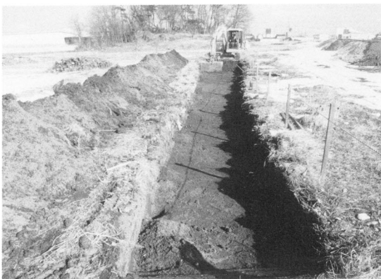
試掘トレンチ
