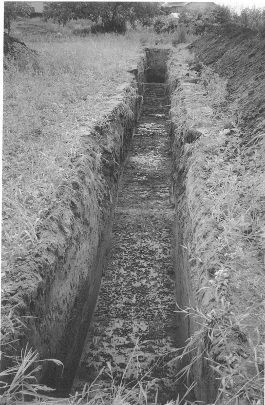
試掘トレンチ
