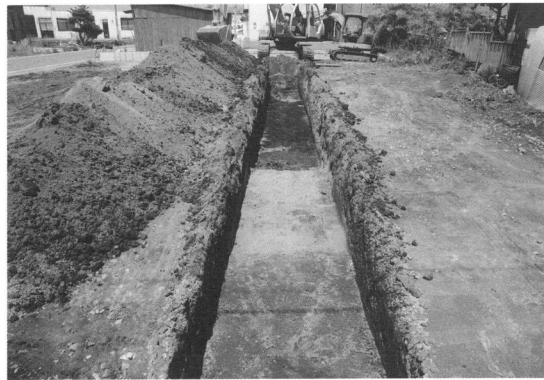
試掘トレンチ
