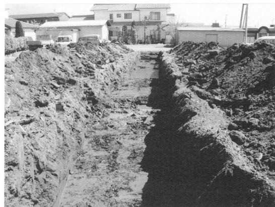
試掘トレンチ
