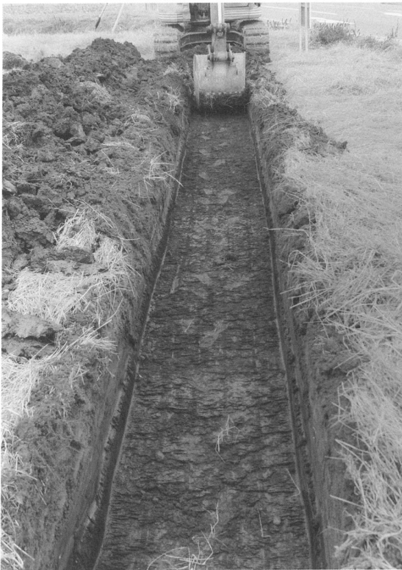
試掘トレンチ
