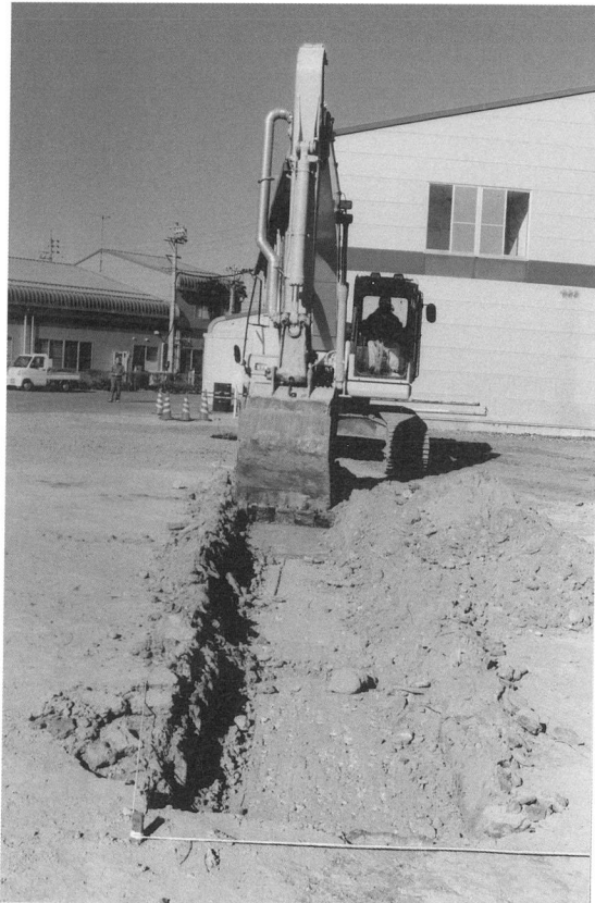
試掘トレンチ
