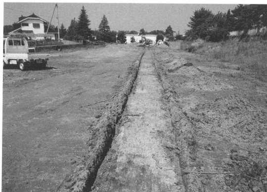
試掘トレンチ
