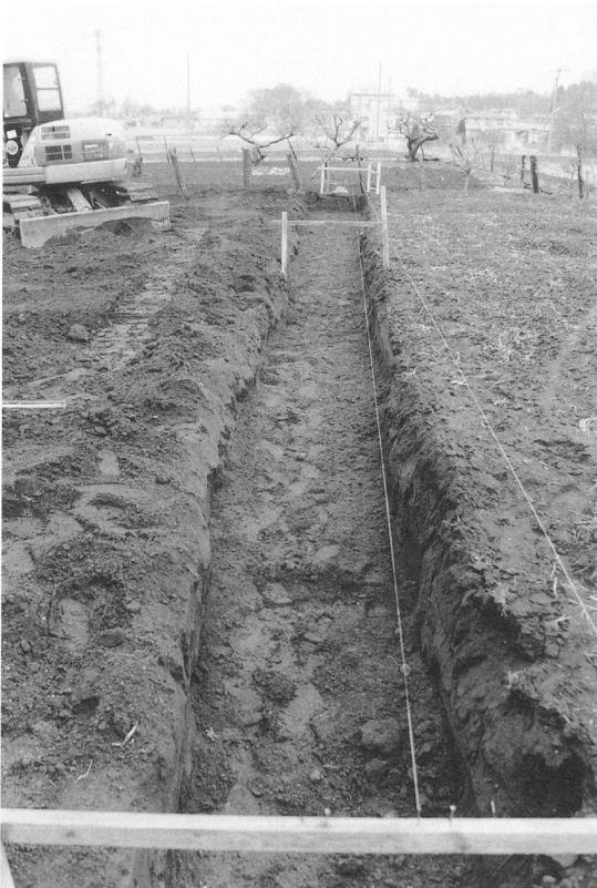
掘削・堆積状態
