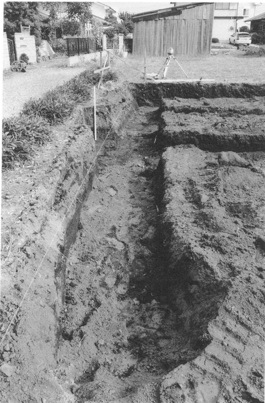
掘削・堆積状況
