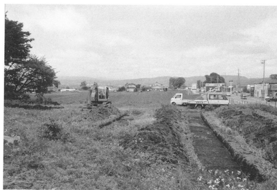
試掘トレンチ
