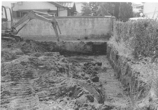
掘削・堆積状況
