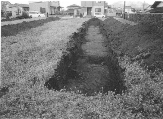
試掘トレンチ
