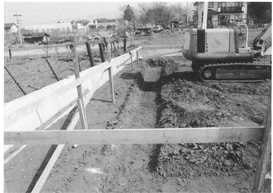
掘削・堆積状態
