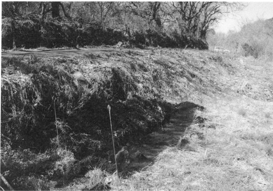
試掘トレンチ
