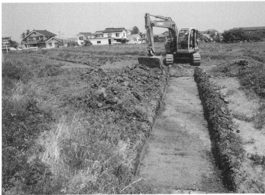
試掘トレンチ
