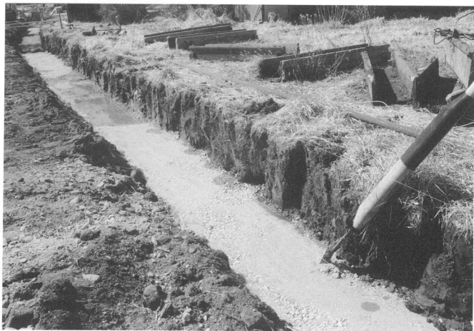
掘削・堆積状況
