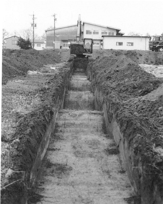
試掘トレンチ
