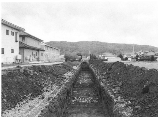
試掘トレンチ
