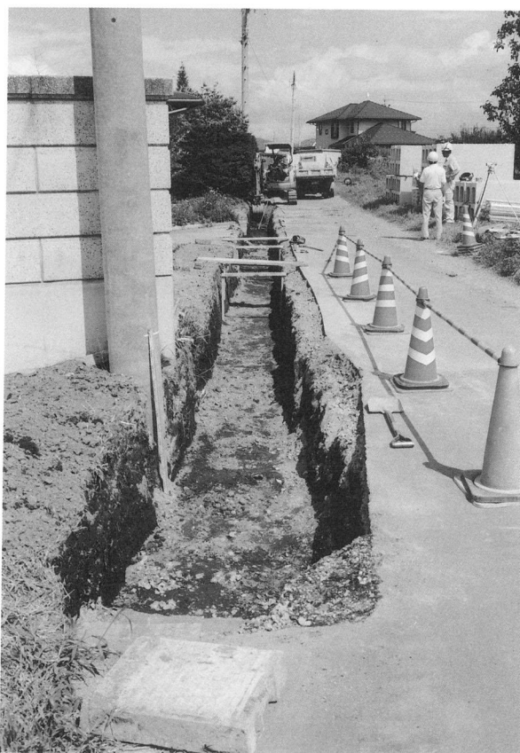
掘削・堆積状況
