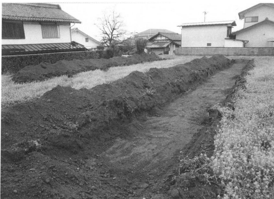
試掘トレンチ
