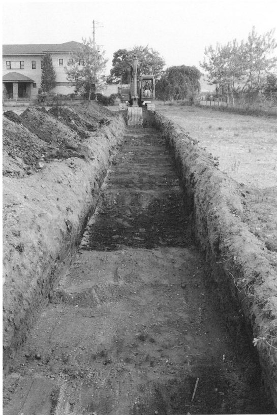
試掘トレンチ
