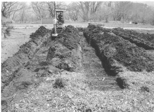
試掘トレンチ
