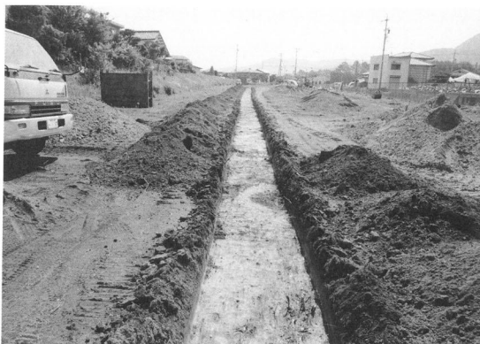
試掘トレンチ
