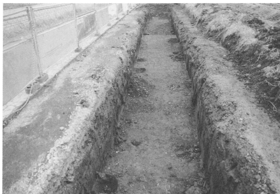
試掘トレンチ
