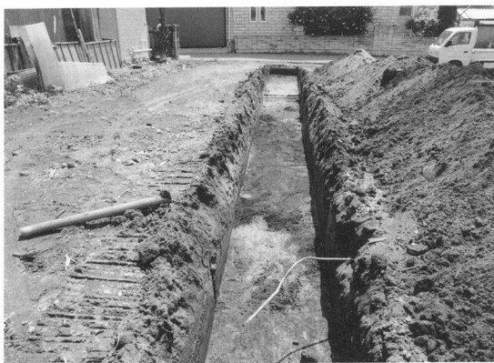
試掘トレンチ
