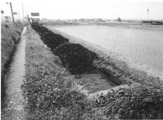
試掘トレンチ
