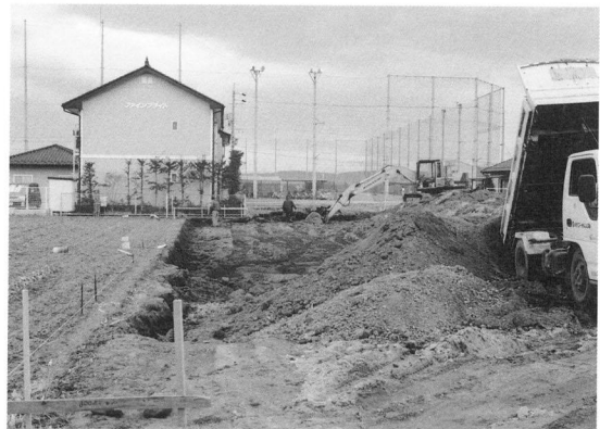
工事立会状況
