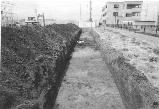
試掘トレンチ
