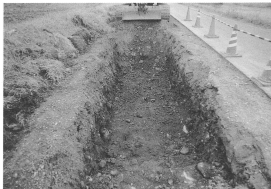
試掘トレンチ
