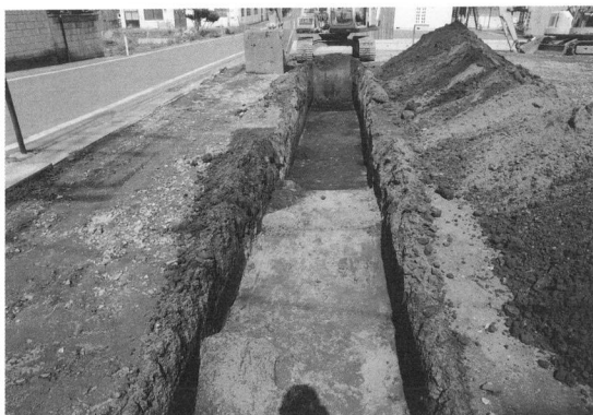
試掘トレンチ
