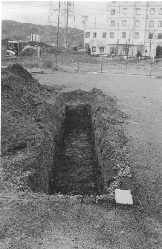
試掘トレンチ
