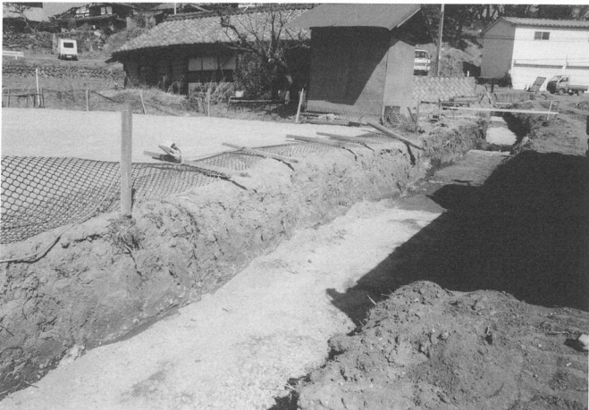
掘削・堆積状況
