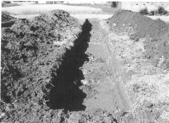
試掘トレンチ
