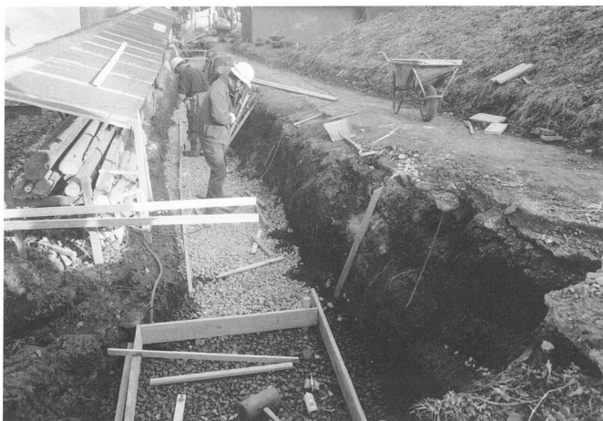
掘削・堆積状況
