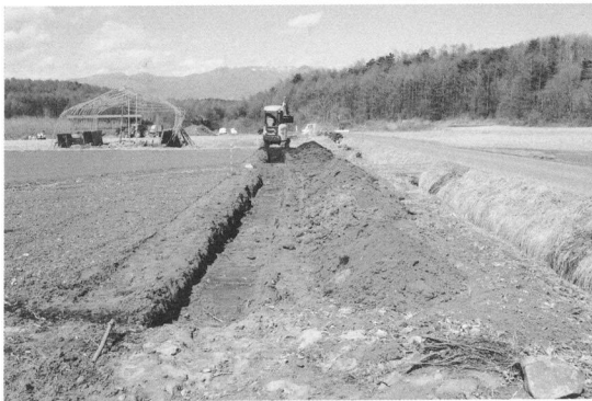
試掘トレンチ
